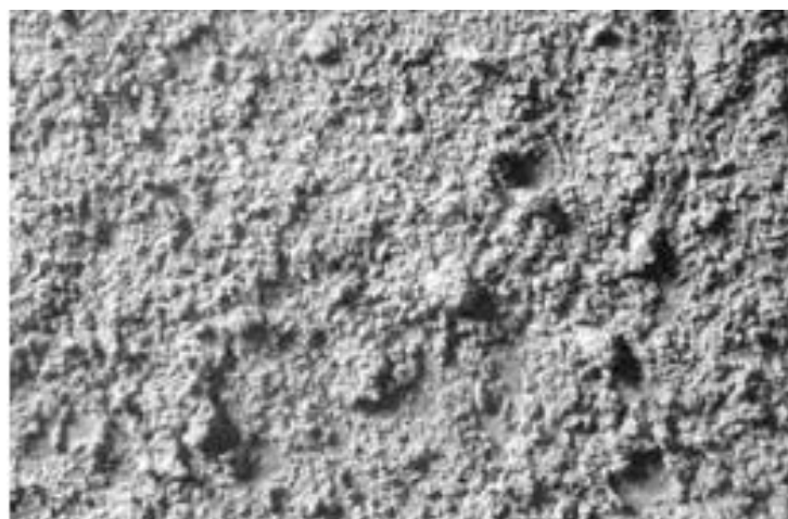
Figura 2 - Superfície com aplicação de chapisco convencional
