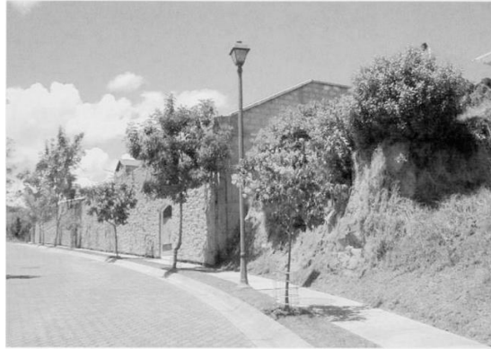
(G) Muros da "urbanização" Altos del Valle em Quito - Equador .
