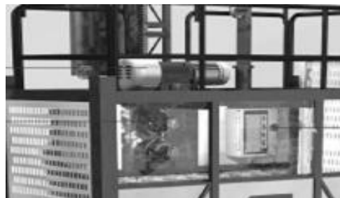
Figura II.5 - Disposição do Sistema na Cabine
