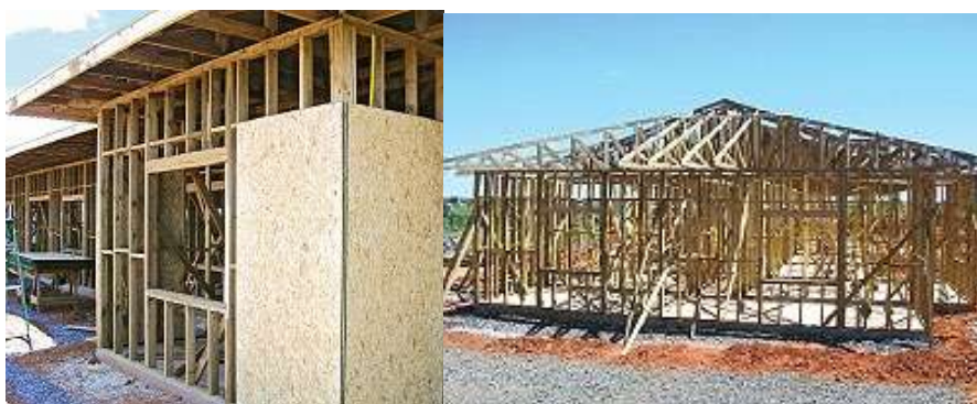
Figura 2: obra sendo executada em Wood Framing (SACCO; STAMATO, 2008, p. 79)
