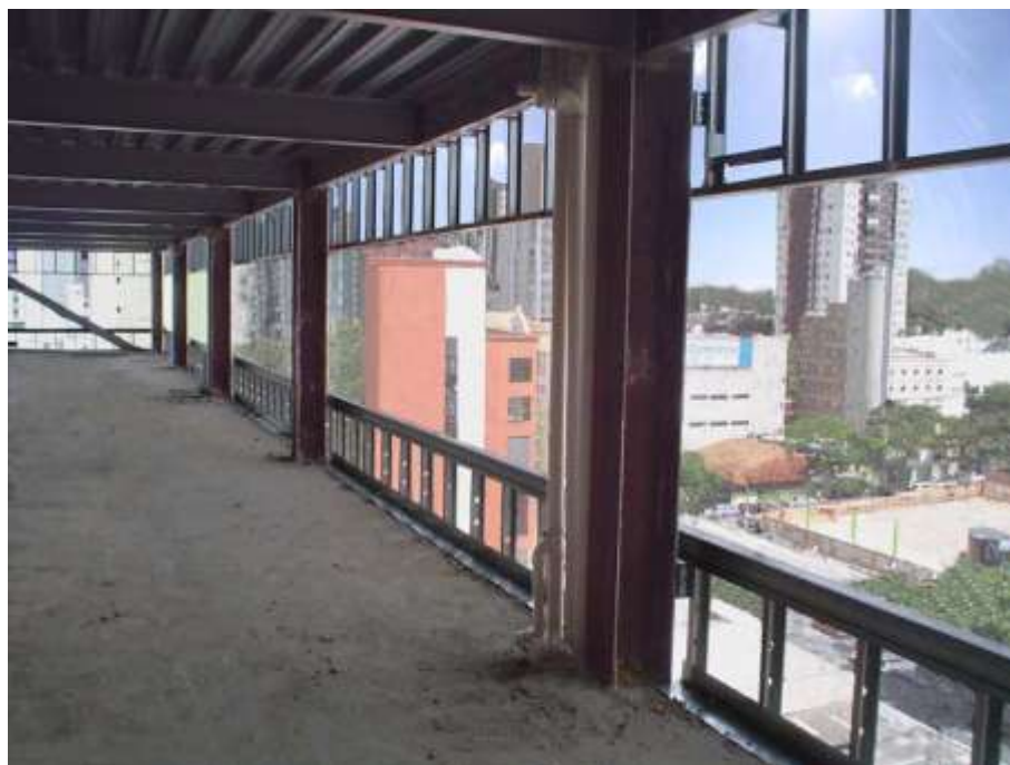
Figura 3: obra com fechamento externo em LSF em Belo Horizonte (SANTIAGO; ARAÚJO, 2008, p. 5)
