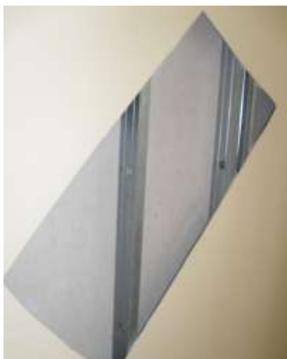
Figura 24: face interna da parede externa com acabamento final
