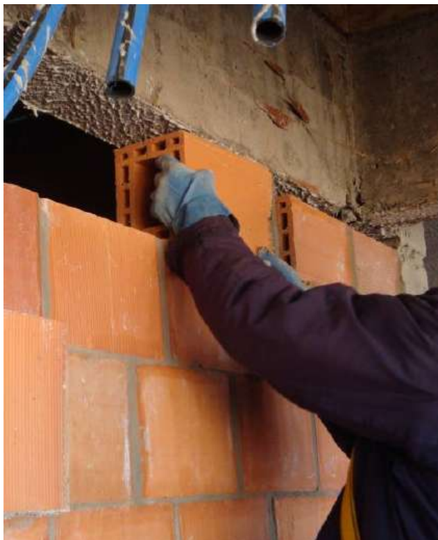
Figura 15: execução da última fiada com bloco cunha
