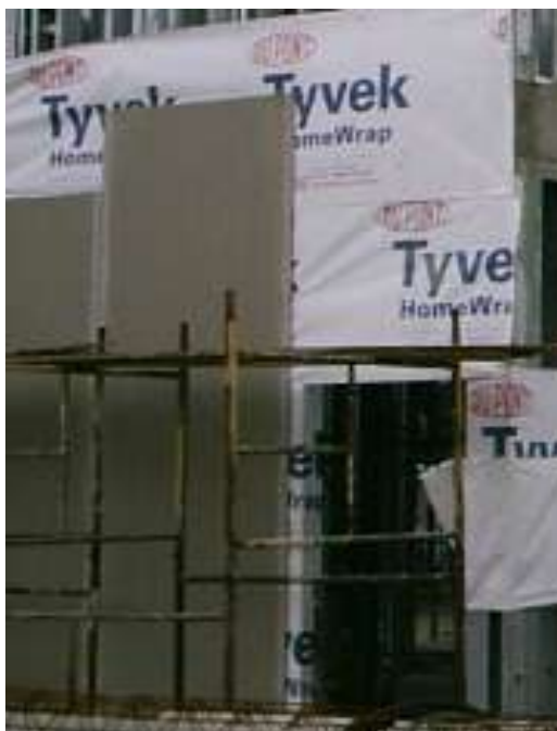
Figura 21: execução de fechamento externo com placa cimentícia
