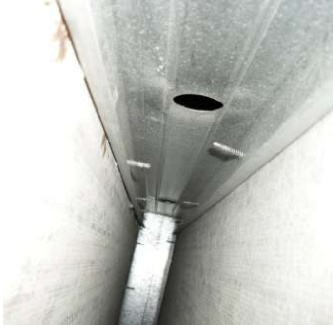
Figura 22: parafusos fixos ao montante após plaqueamento externo e interno
