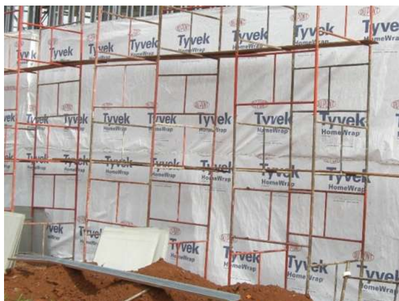
Figura 20: membrana Tyvek
