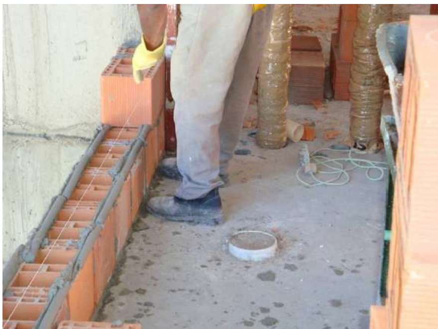
Figura 14: assentamento de blocos com o auxílio do escantilhão e da linha de náilon
