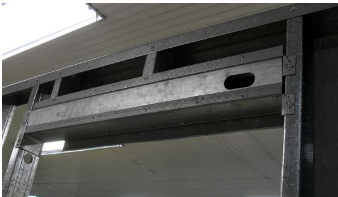
Figura 19: contraverga reforçada (laboratório da Brasilit)
