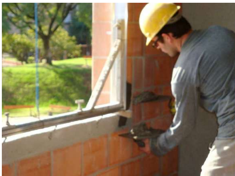
Figura 16: chumbeação dos contramarcos
