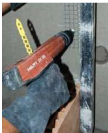
Figura 11: fixação da tela de ancoragem
