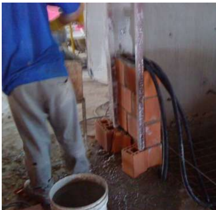
Figura 13: passagem das tubulações elétricas
