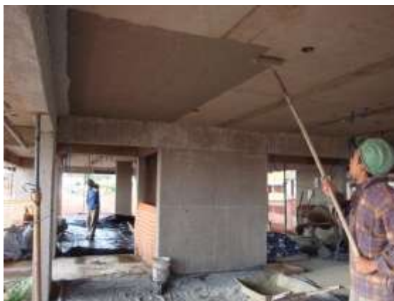
Figura 10: execução de chapisco rolado
