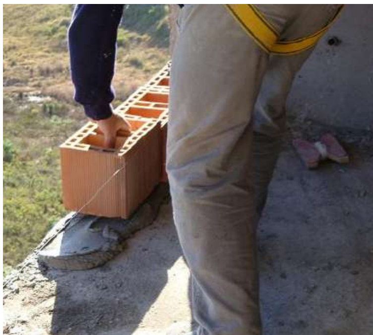
Figura 12: execução da primeira fiada
