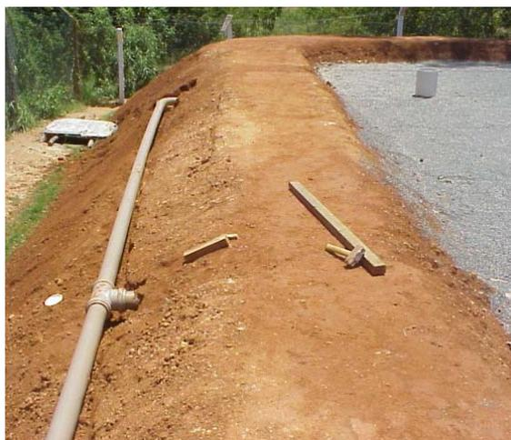
**Figura 77: Sistema de fixação da tubulação de condução da água de reúso.**
