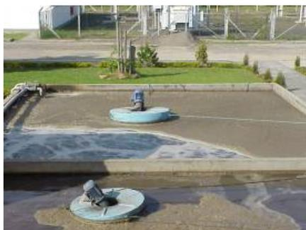
**Figura 25: Sistema de lodo ativado.**
