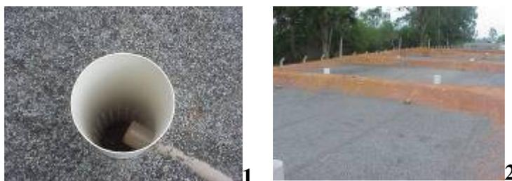
**Figura 40: Sistema de saída de efluente: tubo perfurado (1); controle de nível (2).**
