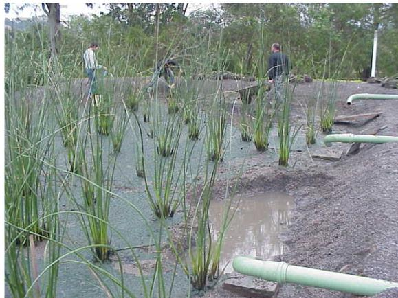
**Figura 80: Excesso de algas devido ao acúmulo de sólidos.**
