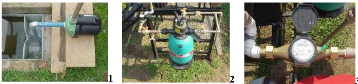
**Figura 32: Etapas de construção do piloto: bomba de recalque (1); filtro (2) e hidrômetros (3).**
