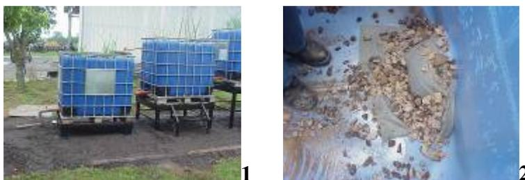
**Figura 31: Etapas de construção da planta piloto: arranjo dos tanques (1); instalação de manta geotêxtil (2).**
