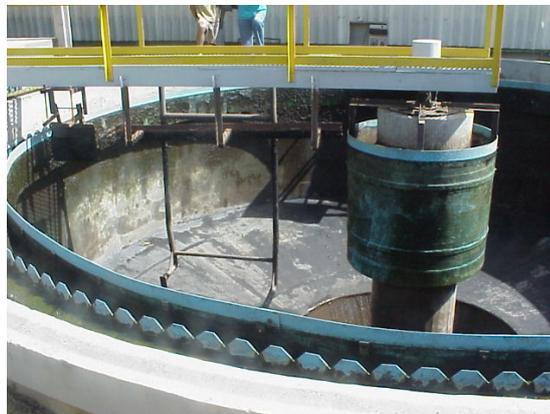
**Figura 81: Conserto da ponte raspadora do decantador secundário.**
