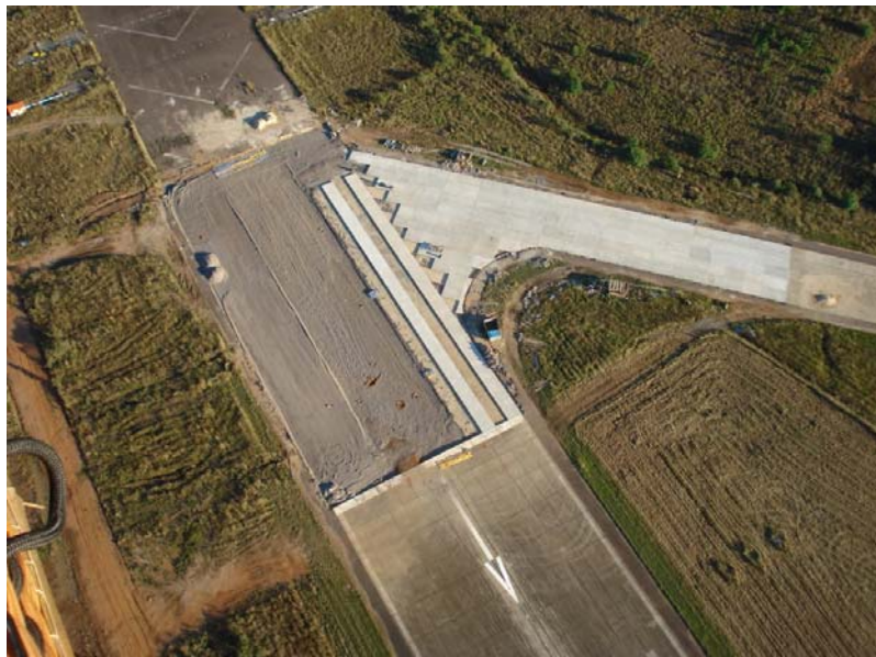
Figura 1.2: Reconstrução de 100 m iniciais da pista de pouso principal e taxiway “A” da Base Aérea de Santa Maria (fonte: LOURES, 2007).
