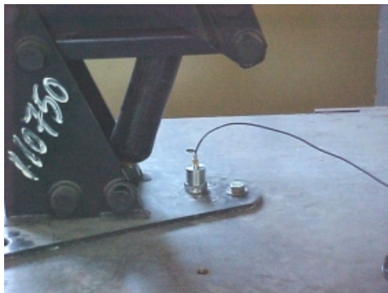
Figura 6.2 - Detalhe do acelerômetro B&K fixado no piso do banco.
