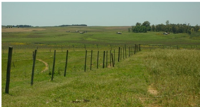
Figura 24 – Lote pelado localizado no PA Santo Ângelo. A figura mostra, ao fundo, um conjunto de três lotes. À direita, um lote com o grande quebra-vento voltado para o sul. Ao centro da figura, um conjunto de casas sem proteção alguma à intempérie. / Foto da autora.
