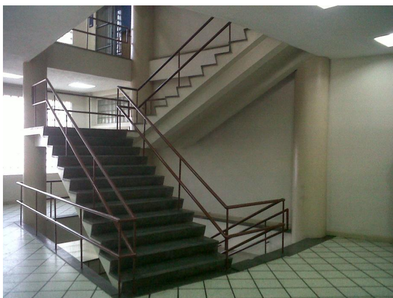
Figura 16 – Atual escada do prédio no 3º pavimento
