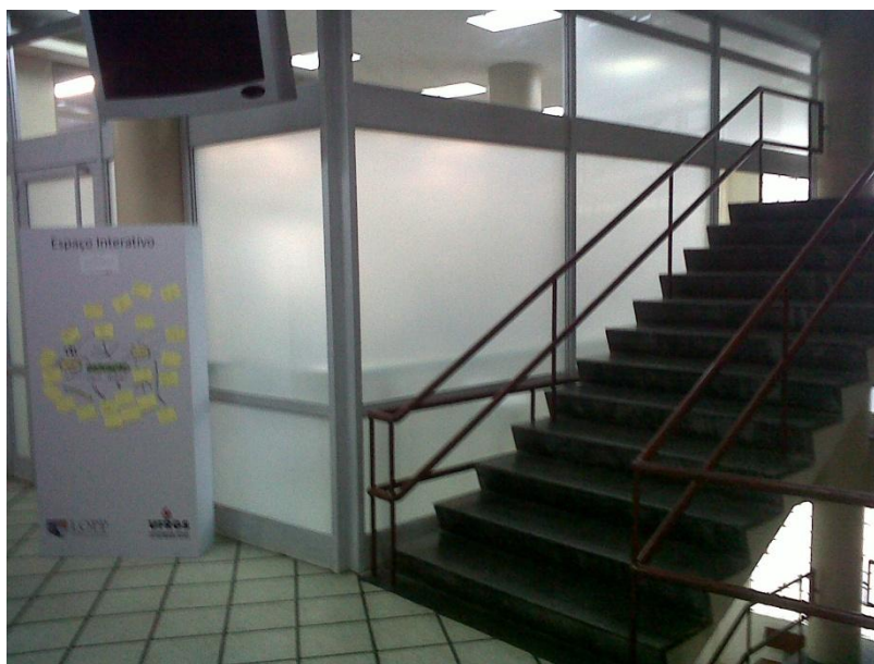
Figura 19 – Escada do 5° ao 6° pavimento do prédio
