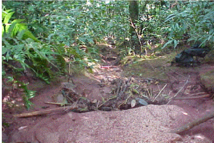
FIGURA 20: Aspectos do Processo Erosivo no Interior do Capão Sul
