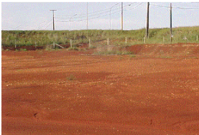
FIGURA 22 - Aspecto da Área Terraplenada, Marginal à Rodovia de Acesso
