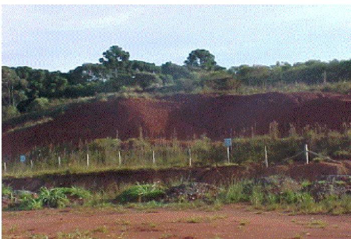
FIGURA 23 - Aspecto do Talude Marginal à Rodovia BR 277
