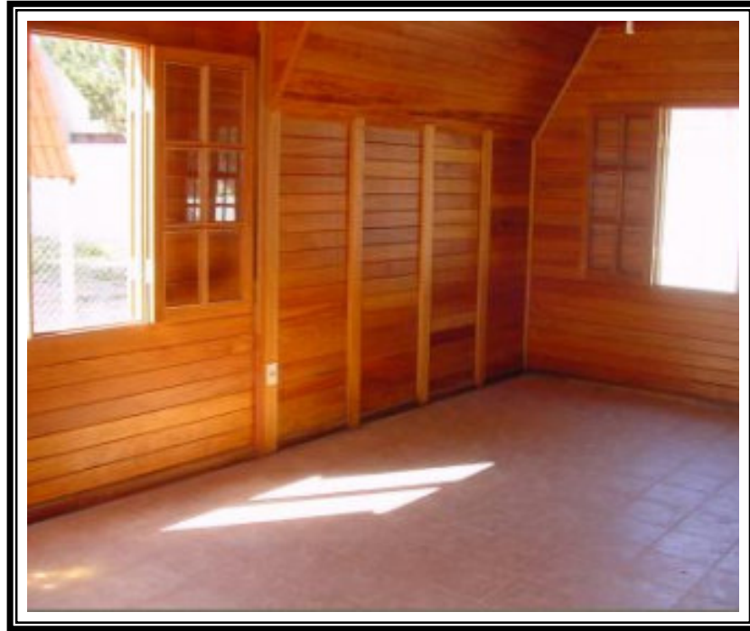
Figura 26: Parede de Painéis de Madeira.
