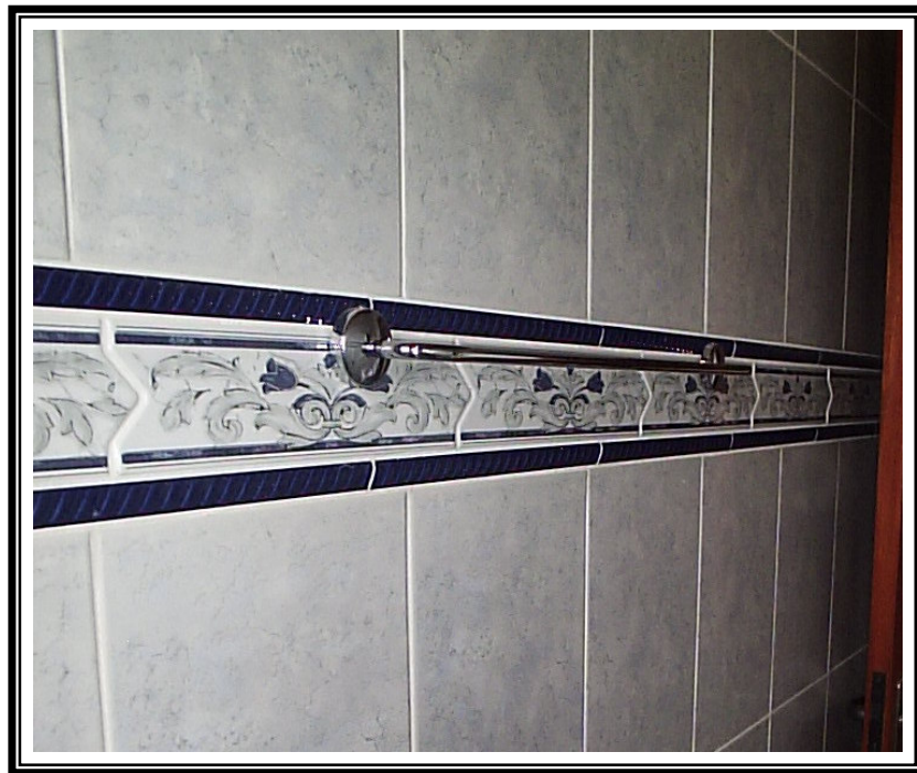
Figura 33: Revestimento de Parede com Cerâmica.
