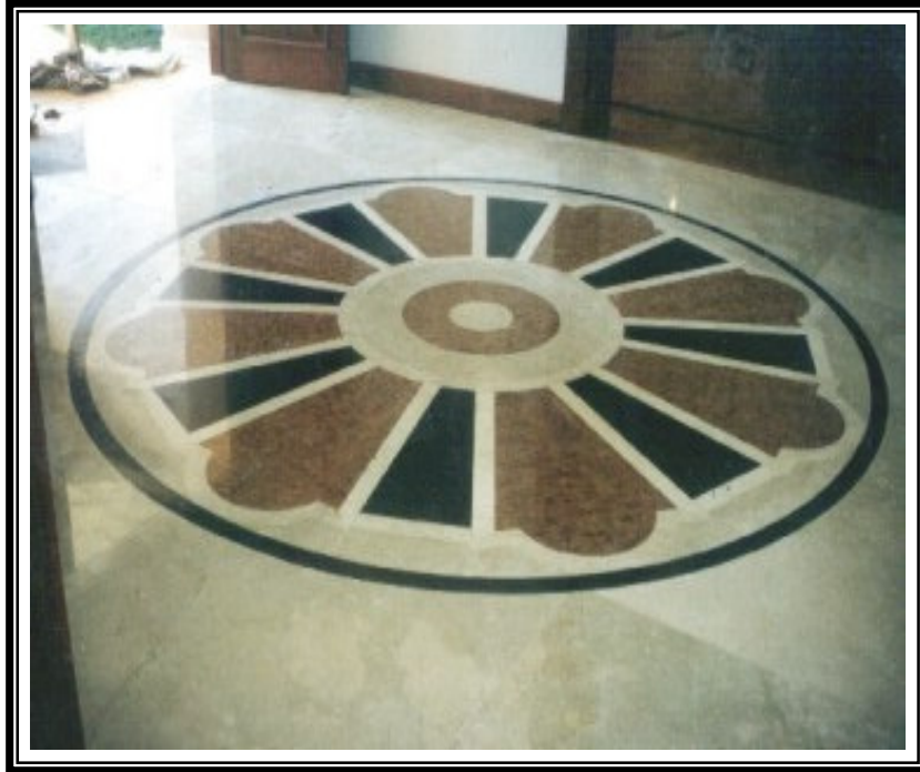
Figura 19: Revestimento de Piso em Pedra Natural (Granito).
