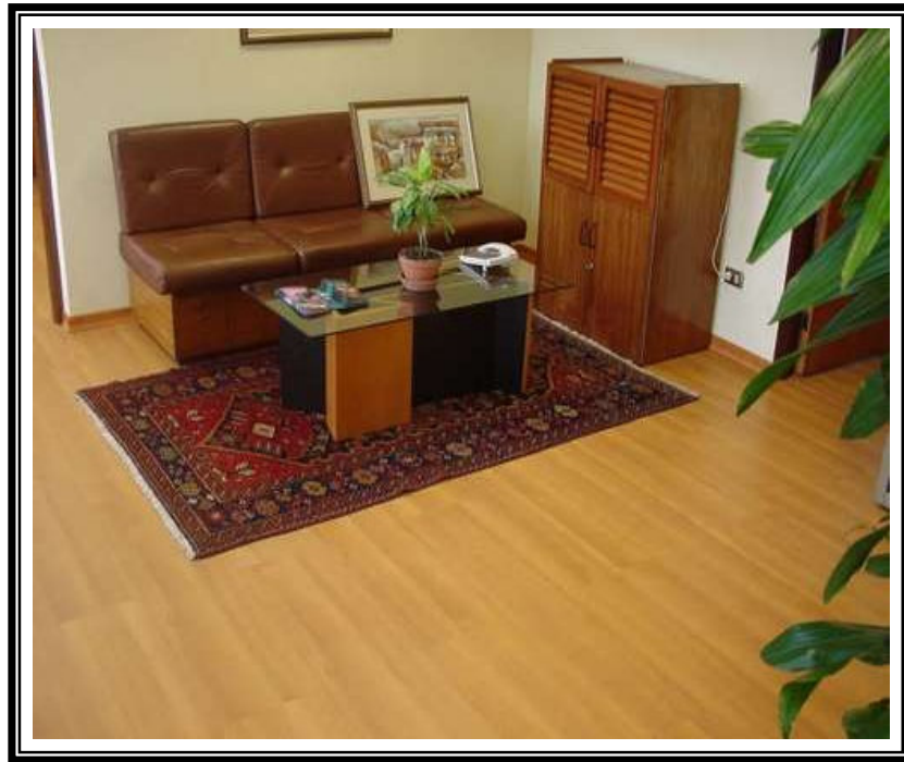
Figura 18: Revestimento de Piso em Laminado Melamínico.
