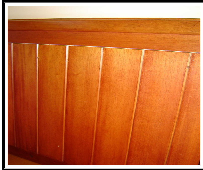
Figura 35: Revestimento de Parede com madeira.
