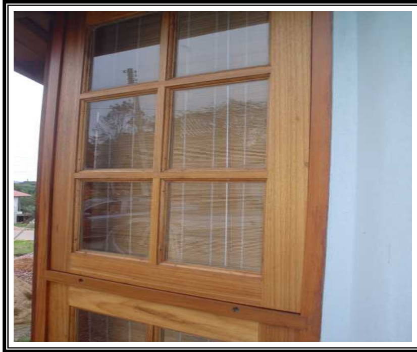
Figura 38: Esquadria de Janela em Madeira
