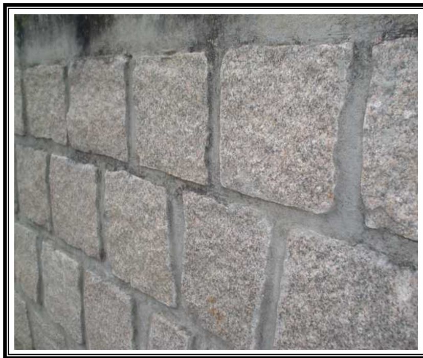
Figura 11: Fundação em Pedra Natural (Granito ).
