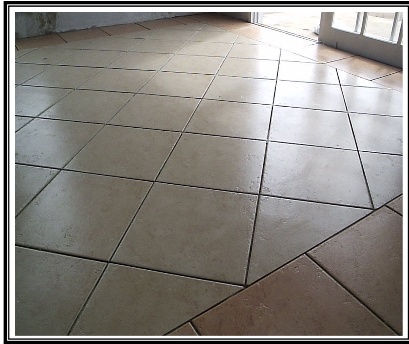
Figura 16: Revestimento de Piso em Cerâmica.
