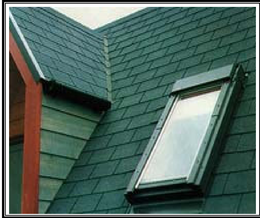
Figura 52: Revestimento de Telhado com telha asfáltica. (ONDULINE, 2005)
