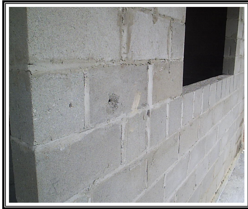
Figura 25: Parede de Alvenaria de Bloco de Concreto.
