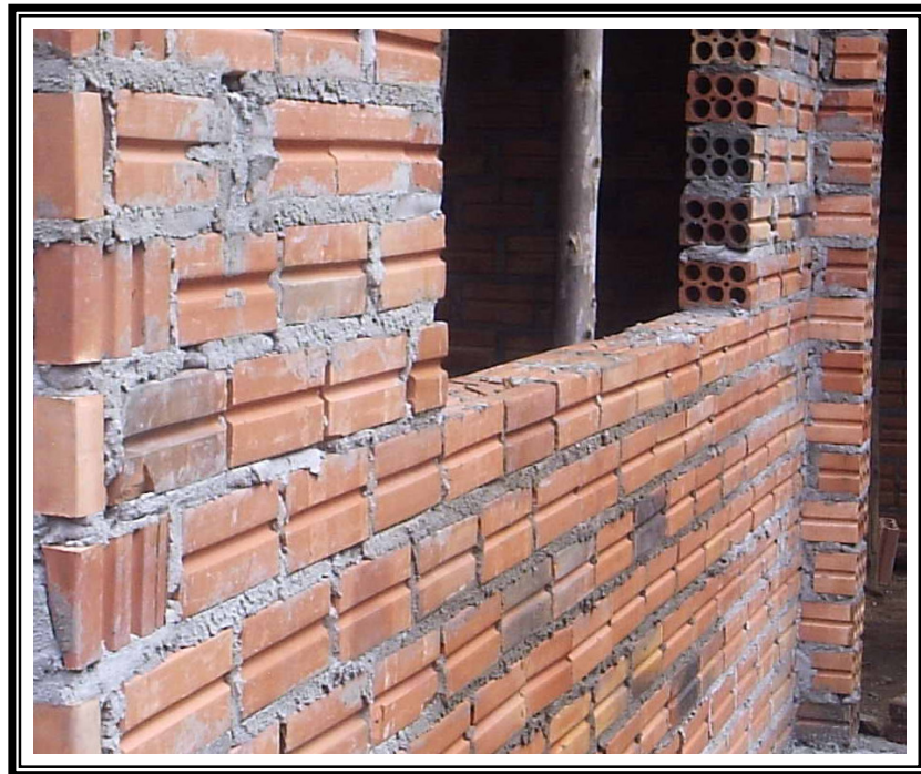
Figura 23: Parede de alvenaria de tijolos.
