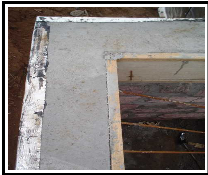
Figura 10: Fundação em Concreto Armado Convencional.
