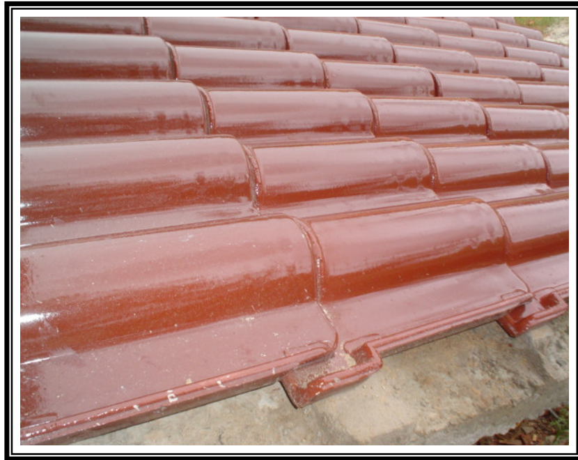
Figura 49: Revestimento de Telhado com telha cerâmica
