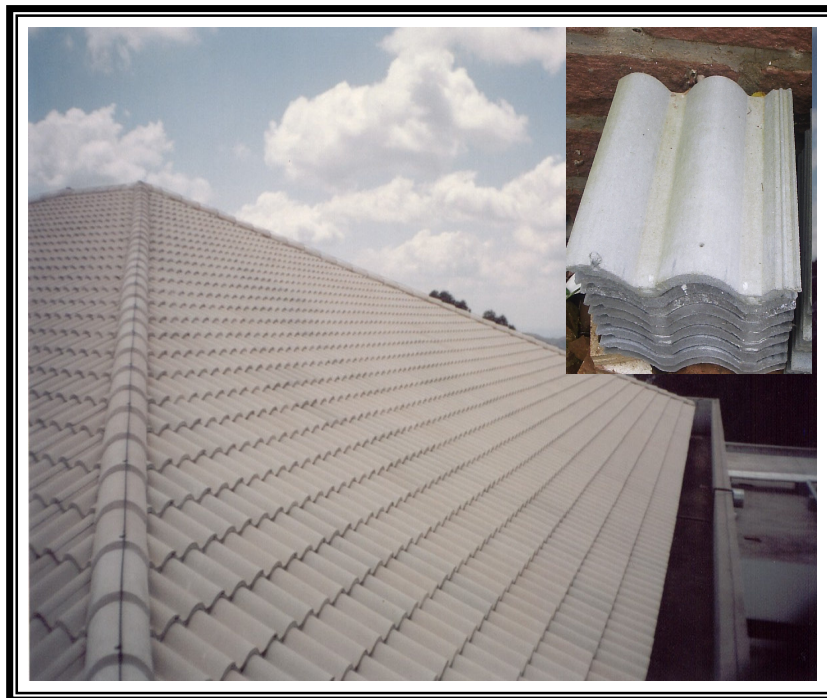
Figura 51: Revestimento de Telhado com telha de concreto.
