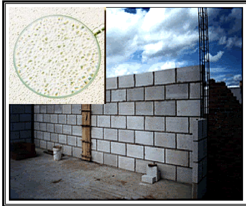
Figura 28: Parede de Bloco de Concreto Autoclavado e detalhe.
