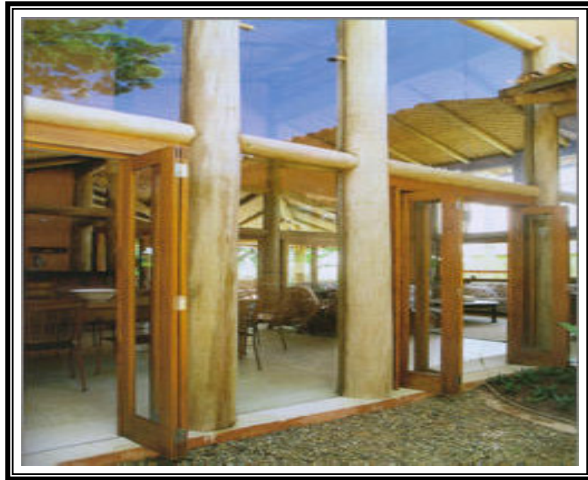
Figura 13: Estrutura em Madeira. Fonte: ORBITAL, 2005
