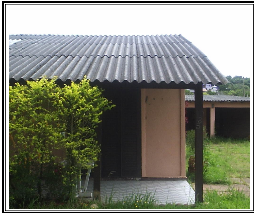
Figura 50: Revestimento de Telhado com telha de fibrocimento.
