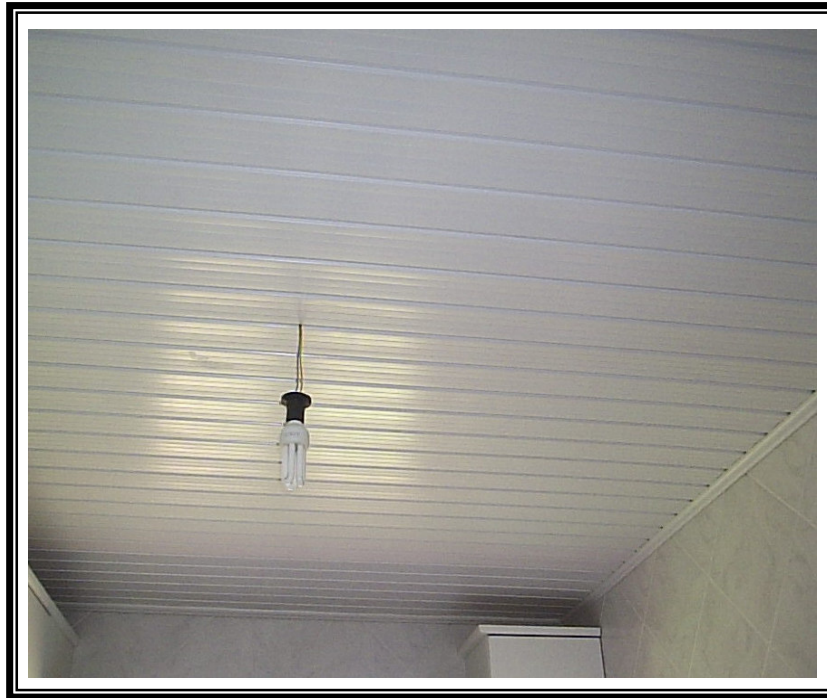
Figura 45: Forro de PVC.
