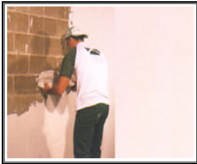
Figura 34: Revestimento de Parede com gesso. Fonte: PALEGESSO, 2005
