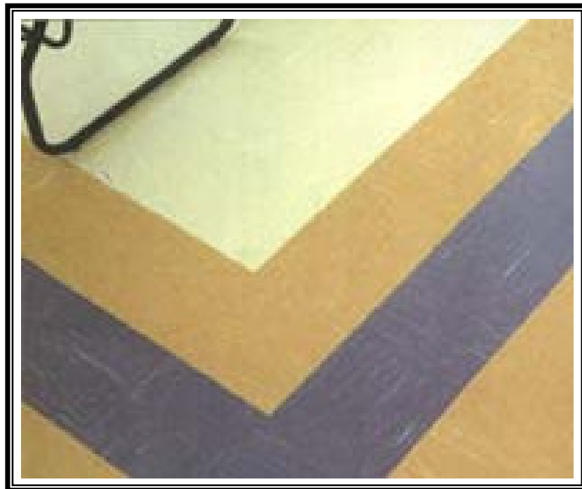
Figura 20: Revestimento de Piso em Vinílico. Fonte: FEDEMAC, 2005
