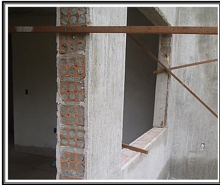
Figura 30: Revestimento de Parede com emboço e/ou reboço
