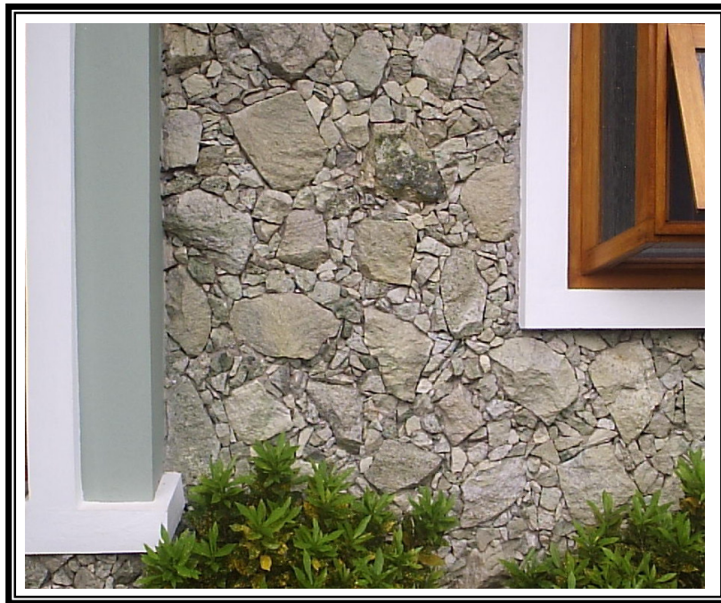
Figura 36: Revestimento de Parede com Pedra Natural
