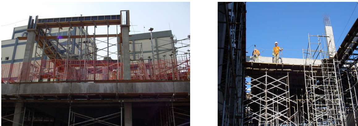
Figura 17: Trabalho em altura no canteiro da obra 2
