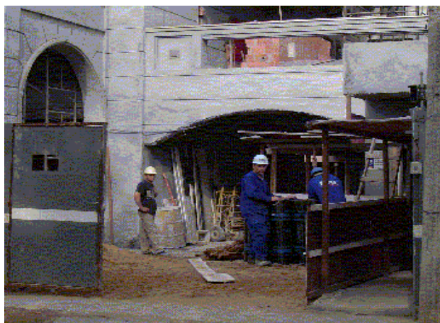
Figura 6: Canteiro da obra 1
