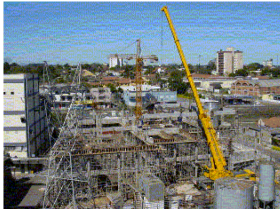
Figura 7: Canteiro da obra 2
