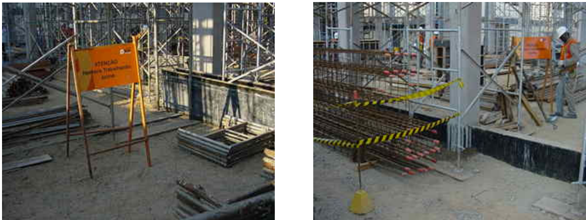
Figura 16: Sinalização no canteiro da obra 2
