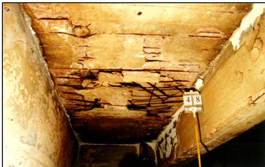
**Figura 3.10** - Aparência de uma estrutura tipo laje após um incêndio
