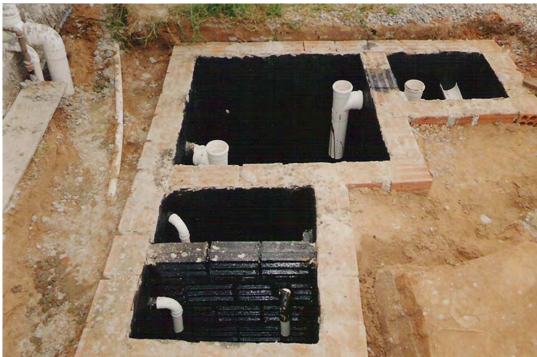
Figura 62: decanto-digestor, filtro anaeróbio e decantador agrupados, em construção junto à moradia de uma família de agricultores assentados.
