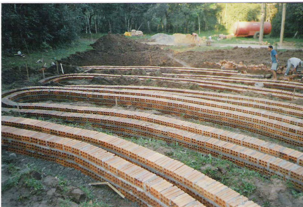
Figura 70: início da construção do LETI.
