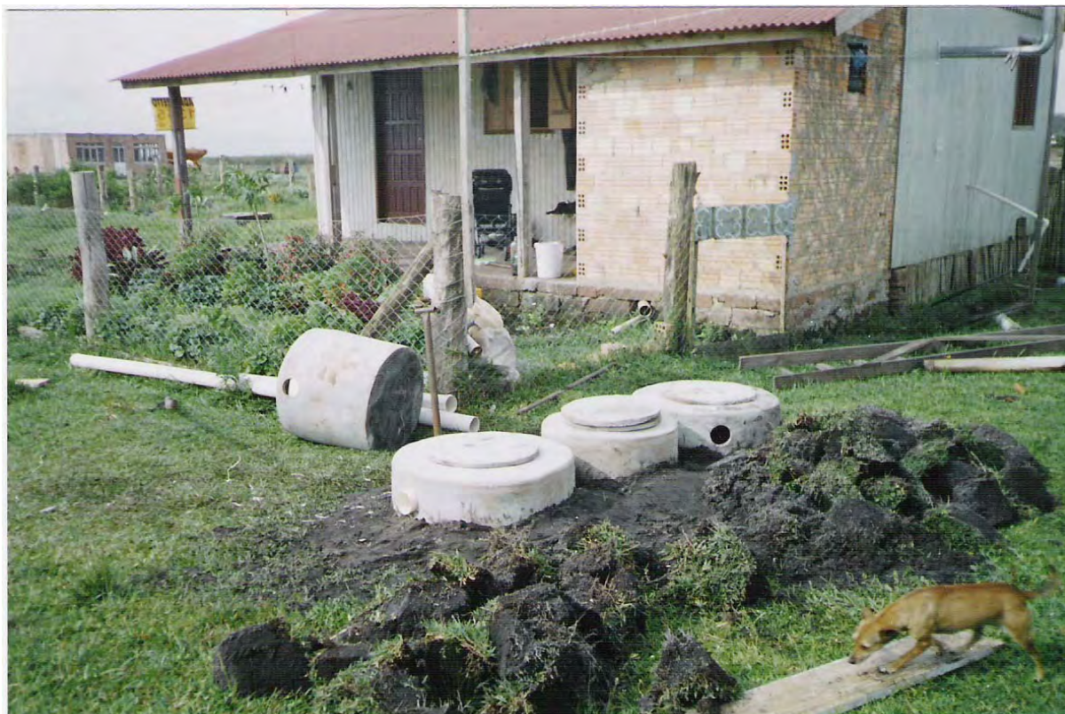
Figura 63 : reator anaeróbio composto por três fossas de ferrocimento, dispostas em série, sendo implantadas na moradia de uma família de agricultores assentados.
