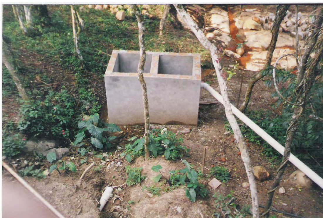
Figura 67: decantador para as águas cinzas do restaurante.
