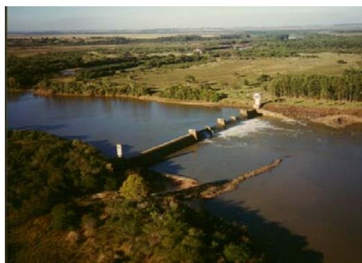
Fonte: CODESP/AHSUL (2004) Figura 4 Barragem do Anel de Dom Marco
