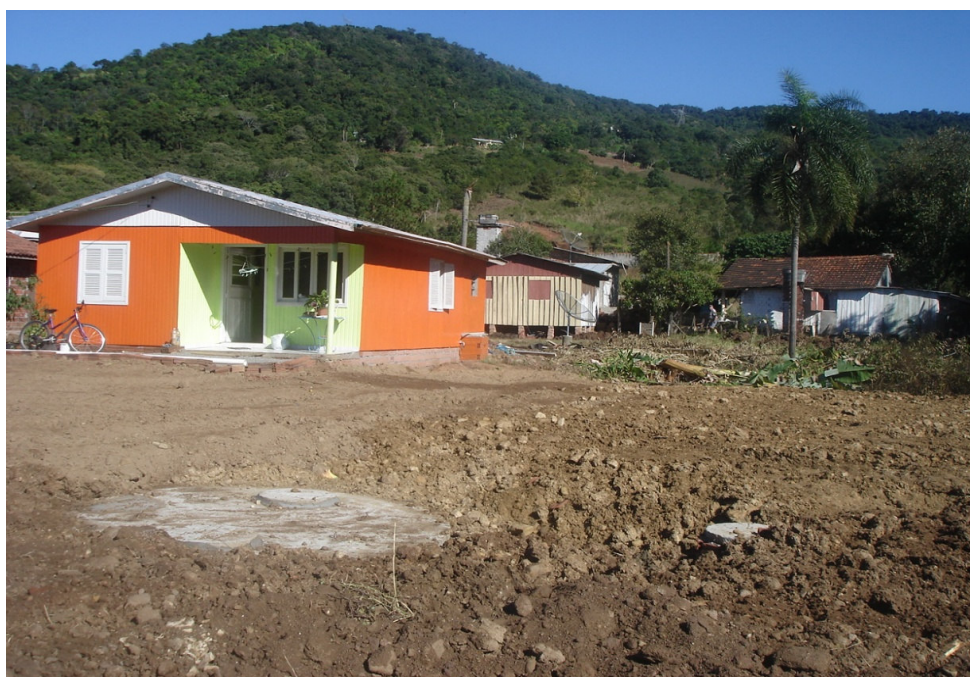
Figura 40: Estação de tratamento de esgoto sanitário da Rua Ermindo Mayrer, em 06/05/2009 (Fonte: Prefeitura Municipal de Feliz)
