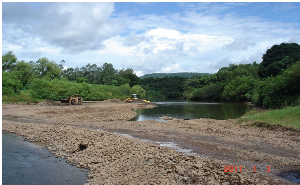
Figura 11: Retirada de cascalho no rio Caí (Fonte: O Autor)
