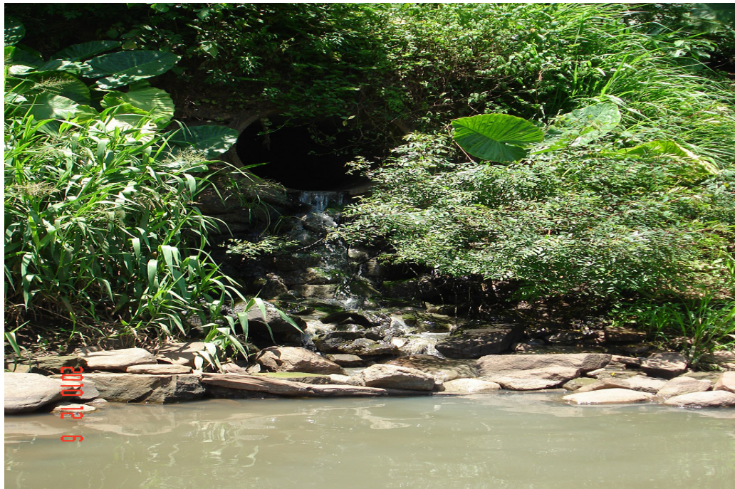
Figura 23: Lançamento da rede de drenagem superficial mista.
