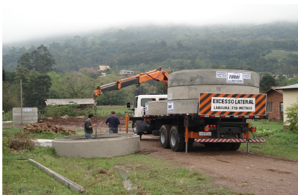
Figura 38: Chegada de material para construção da estação de tratamento de esgoto sanitário da Rua Ermindo Mayrer, em 19/08/2008. (Fonte: Prefeitura Municipal de Feliz)
