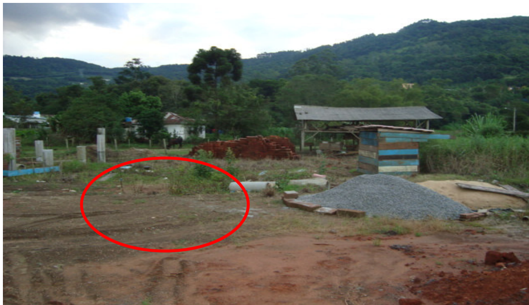
Figura 41: Estação de tratamento de esgoto sanitário da Rua Ermindo Mayrer, em 30/03/2011.
