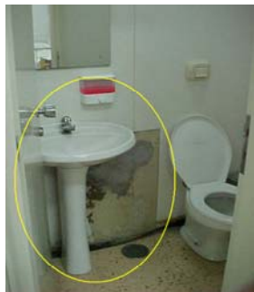
Figura 111: Sanitário da sala de recuperação
