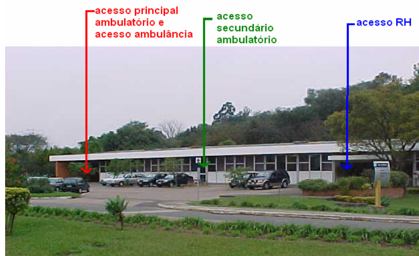
Figura 106: Fachada principal da edificação que abriga os setores de RH e Serviço médico da empresa
