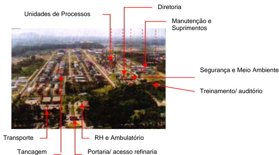
Figura 103: Foto aérea da refinaria
