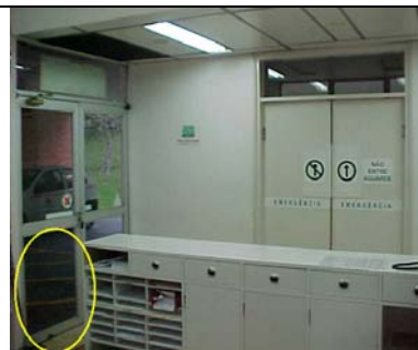
Figura 117: Passagem entre o armário e o balcão de atendimento: ponto crítico de circulação da sala
