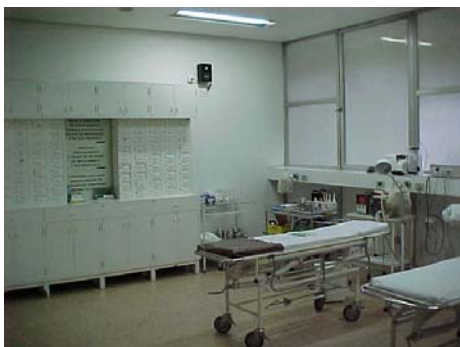
Figura 146: Vista dos leitos e do armário alto
