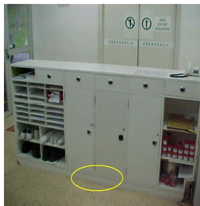
Figura 84: Vista do balcão de atendimento para o lado da sala de enfermagem
