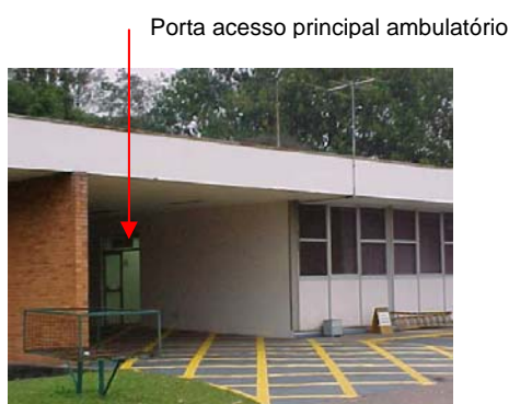
Figura 107: Local semicoberto destinado ao estacionamento da ambulância do ambulatório
