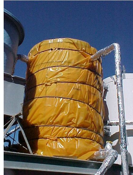
Figura 4.7 – Isolamento adicional de poliuretano. Figura 4.8 – Enlonamento para diminuir a ação do vento.
