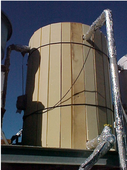
Figura 4.7 – Isolamento adicional de poliuretano. Figura 4.8 – Enlonamento para diminuir a ação do vento.
