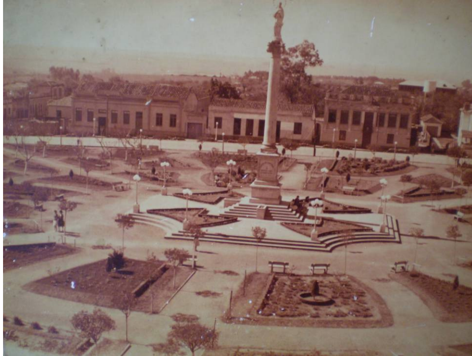
Figura 25 – Praça Moisés Viana após rebaixamento do terreno e restauração Fonte: Acervo do Dr. Valdir do Amaral Pinto
