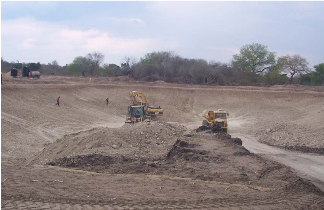
Figura 21 - Represa em construção no distrito de Funhalouro
