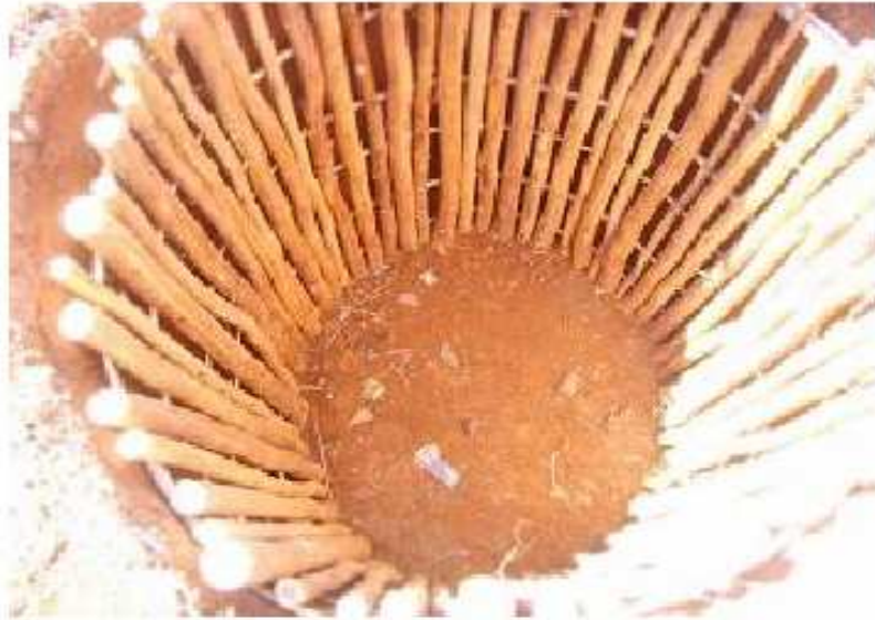
Figura 36 - Fossa circular com revestimento de estacas de madeira
