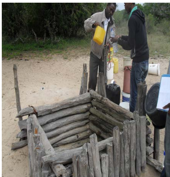
Figura 18 - Poço sem proteção
