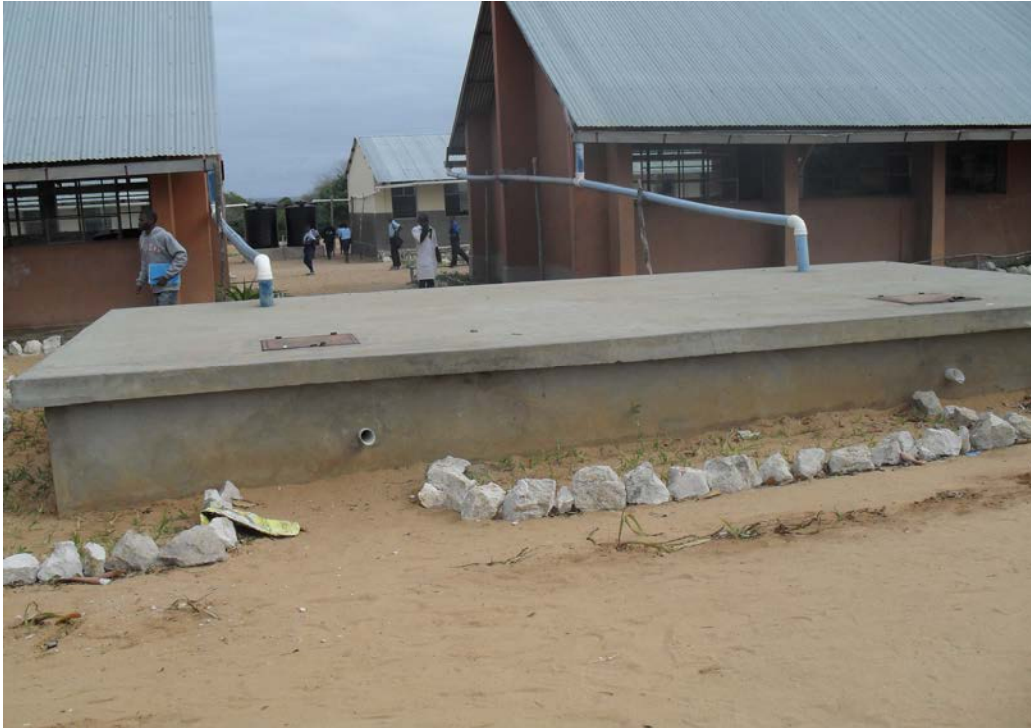
Figura 41 - Cisterna construída em escola primária
