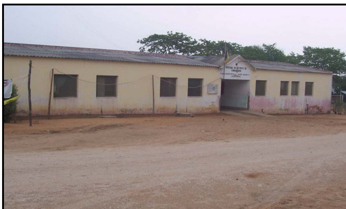
Figura 5 - Centro de saúde de Mucuíne (vila-sede do distrito)
