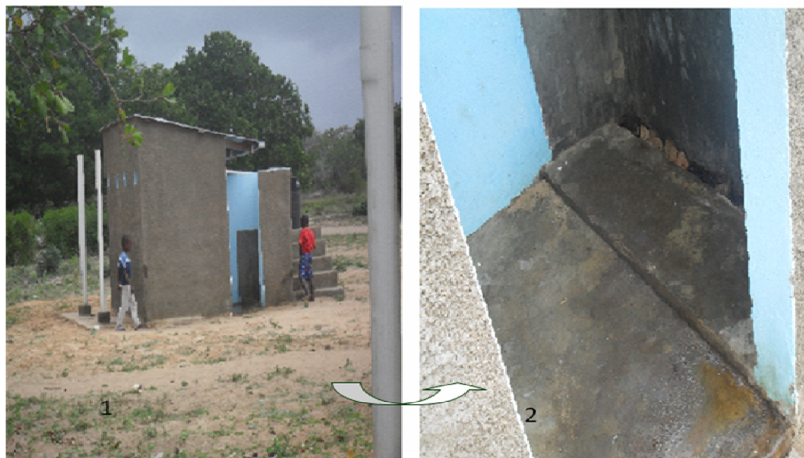
Figura 8 - Criança urinando fora do Banheiro (1) e parte interna do banheiro (2)
