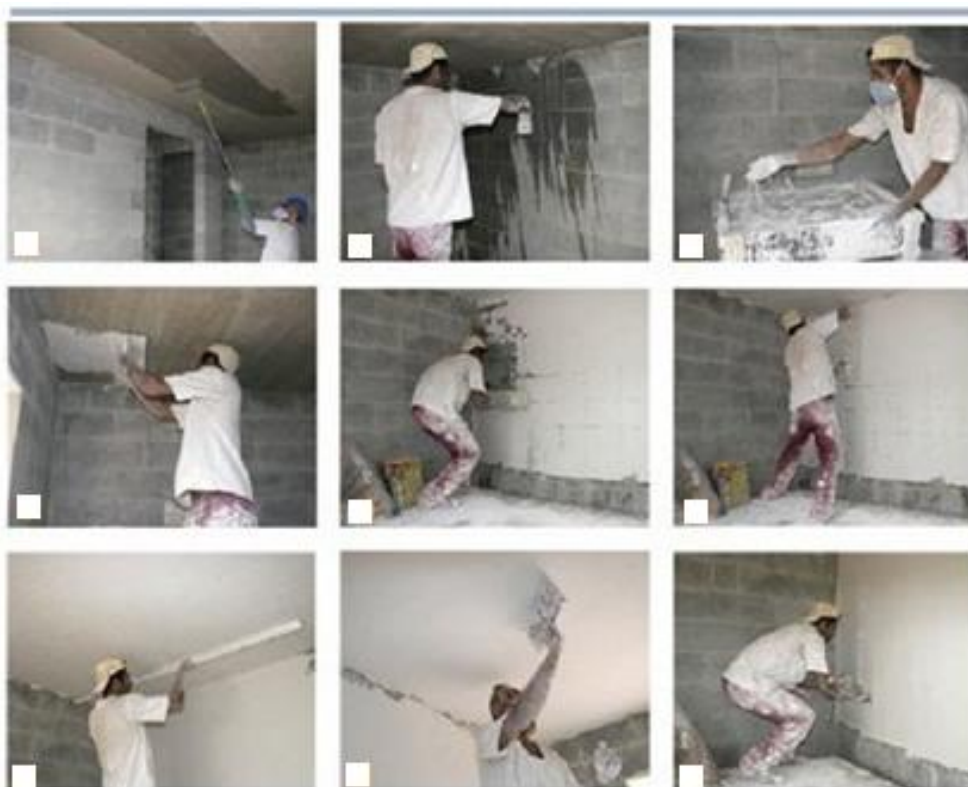
Figura 4 – Processo de execução do revestimento desempenado
