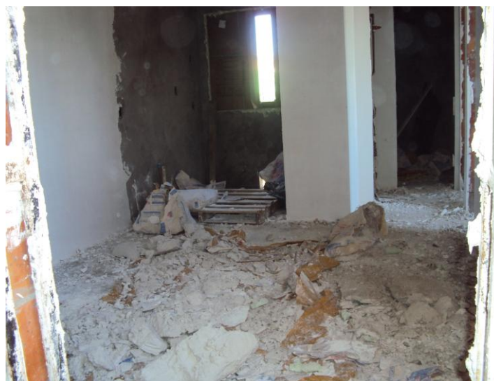
Figura 14 – Quantidade resíduo após a execução do revestimento com pasta de gesso
