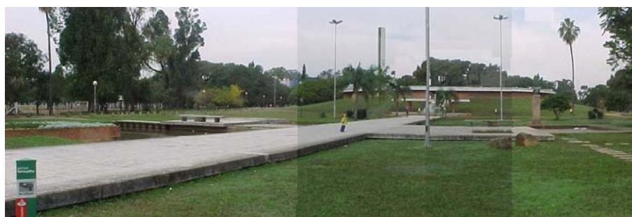
Figura nº 83. Auditório sem cobertura fotomontagem. Fonte: arquivo SMAM.
