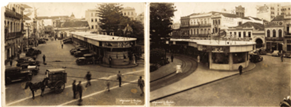
Figura 45 e Figura 46: Abrigo de Bondes da Praça XV. Fotos antes da ampliação. Projeto de Adolpho Siegert. Fonte: (Jornal do Mercado, 2011)
