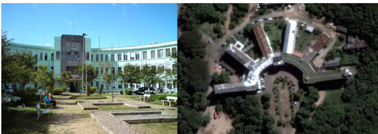
Figura 116 e Figura 117: Sanatório Belém, vista aérea (fonte: Google Earth) e fachada principal (foto Cláudio Calovi Pereira)
