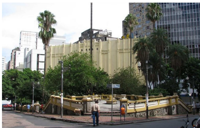
Figura 42: Praça Otávio Rocha. 2009. Vista do terraço sobre os banheiros. Fonte: (prati.com.br)
