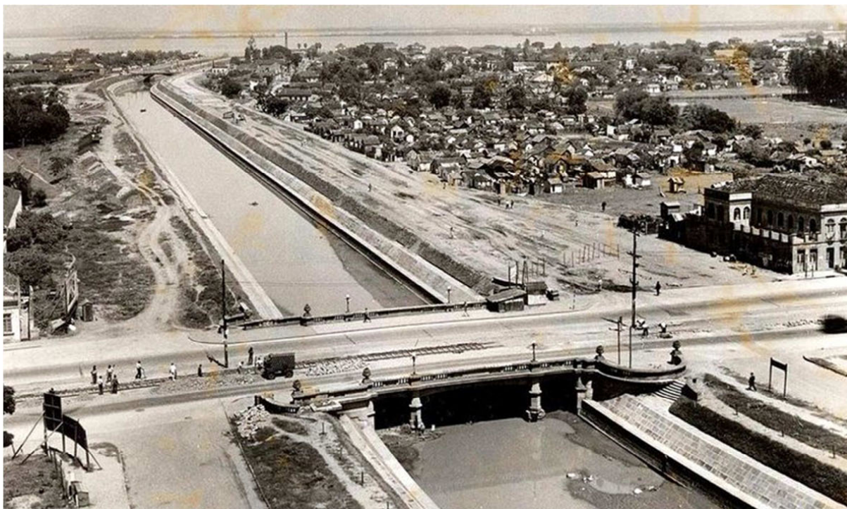
Figura 156: Ponte da Azenha. Fotografia durante a canalização do Riacho. 1940. Fonte: Fotos Prati
