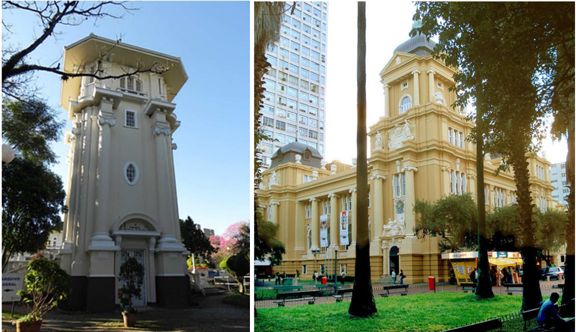
Figura 32 (esq.): Torre da Hidráulica Moinhos de Vento. 2011. Fonte: Claudio Calovi Pereira
