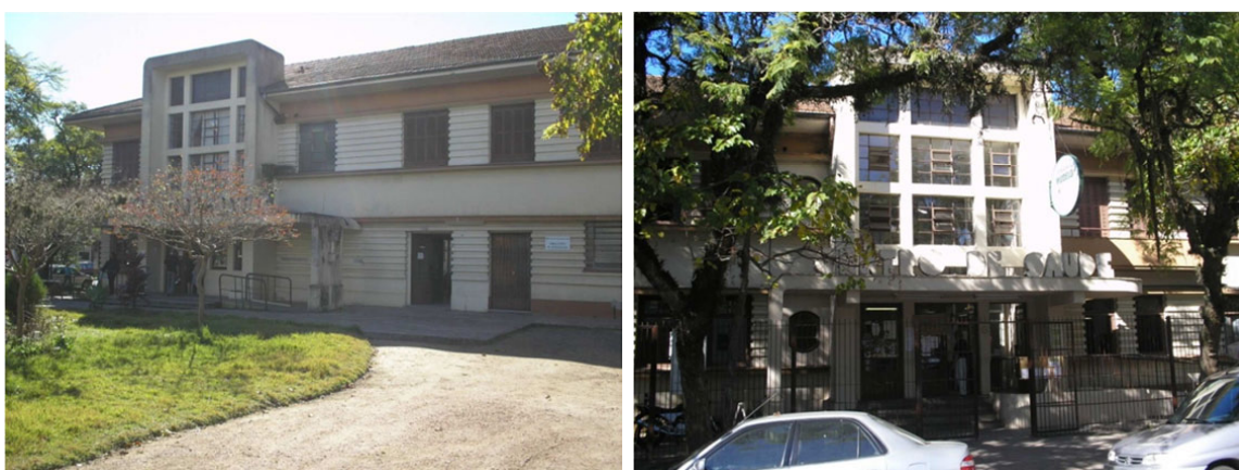
Figura 139: Centro de Saúde Modelo – Fachada Avenida João Pessoa – 2009. Fonte: Cristiano Z. Pereira
