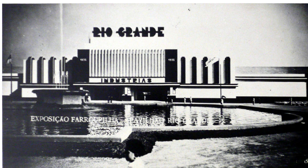
Figura 68: Pavilhão das Indústrias do Rio Grande. 1935. Fachada Frontal. Fonte: ArqCentro-PROPAR.
