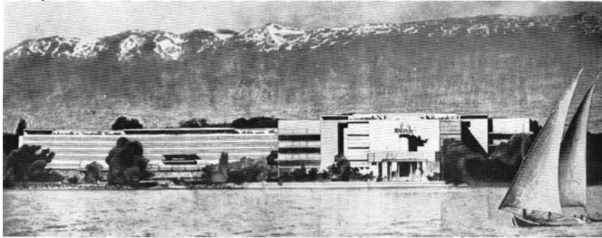
Fig 123: Le Corbusier, Palácio da Sociedade das Nações, face voltada para o lago.
