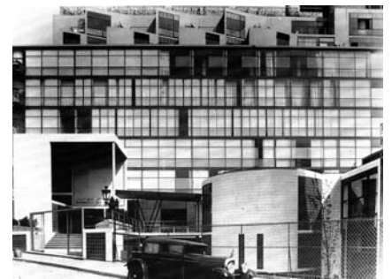
Fig. 246: edifício sede do Exército da Salvação (1929) em Paris, de Le Corbusier, em sua forma original, com a face em cortina de vidro orientada para o poente.
