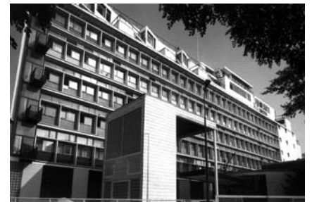
Fig. 247: edifício sede do Exército da Salvação, após as reformas bancadas por Le Corbusier, em que a face de vidro voltada para o sol foi protegida por brise-soleil e a cortina de vidros fixos foi substituída por janelas tipo correr mais peitoril opaco.
