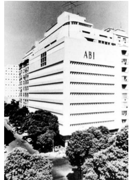
Fig. 240: ABI, vista da esquina.
