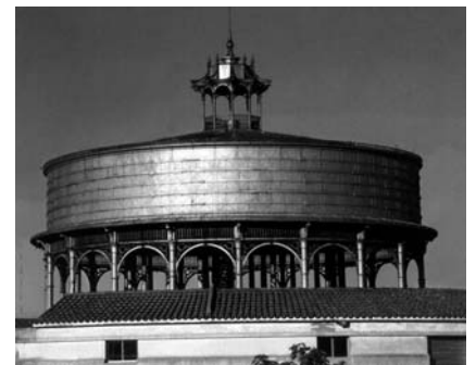
Fig. 150: Caixa d'água em ferro, no Rio Grande do Sul, pré-fabricada na Inglaterra em 1876.
