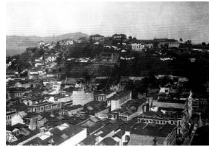
Fig. 160: Vista do Morro do Castelo antes do início do desmonte, ocorrido a partir de 1907.
