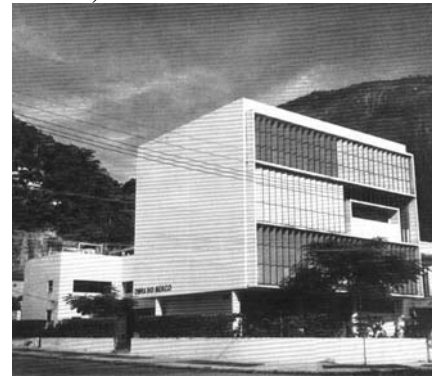
Fig. 243: Obra do Berço, Rio de Janeiro, 1937. Oscar Niemeyer.
