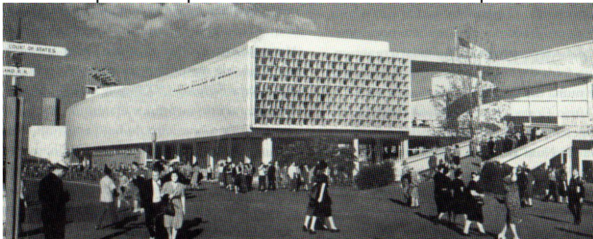
Fig. 258: Pavilhão do Brasil Feira Internacional de Nova Iorque, Lucio Costa, Oscar Niemeyer e Paul Lester Wiener, 1939. Vista da face junto à rua curva.
