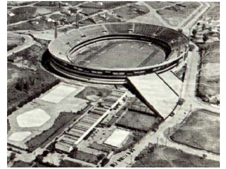
Fig. 328: Vilanova Artigas, Estádio do Morumbi, São Paulo, 1952.
