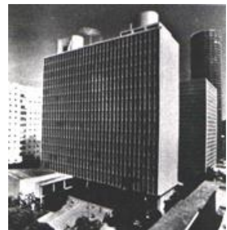
Fig. 229: MESP, vista geral face norte.
