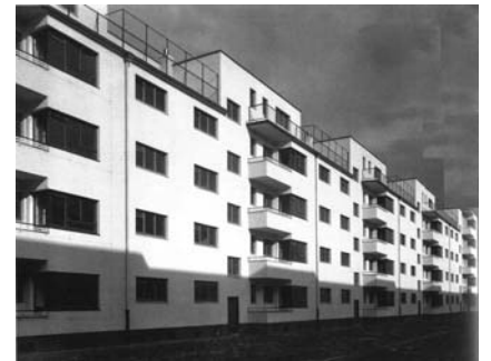
Fig. 106: Siedlungen em Colônia, Bairro Kalkerfeld, 1927, Wilhelm Riphahn.
