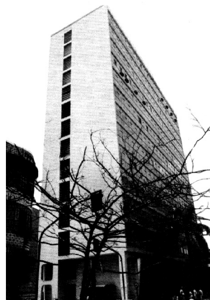
Fig. 315: Adolf Franz Heep e Elgson Gomes. Edifício Souza Naves, 1953.
