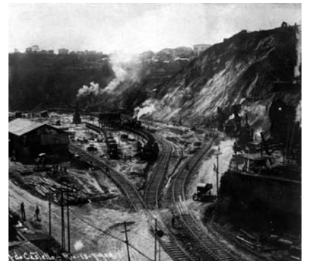
Fig. 161: Vista dos trabalhos de desmonte do Morro do Castelo em 1922.
