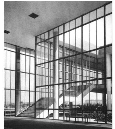
Fig. 223 a: A Faculdade Nacional de Arquitetura (1956), de Jorge Machado Moreira, é um dos quatro edifícios concluídos da inacabada Cidade Universitária, situada na Ilha do Fundão, RJ. Segundo análise de Roberto Segre, "constitui uma homenagem ao MESP, reconhecendo em escala maior, seu sistema compositivo e alguns elementos de referência dos sucessivos projetos precedentes: no vestíbulo principal, aparece a escada imaginada por Le Corbusier para o projeto da praia de Santa Luzia 24 ."
