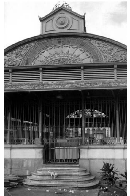
Fig. 149: Pavilhão do mercado de Manaus, pré-fabricado por Walter MacFarlane em Glasgow, Escócia.
