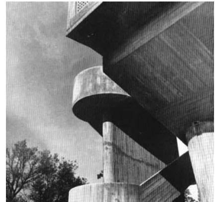
Fig. 286: Unidade de Habitação de Marselha, 1946, Le Corbusier.
