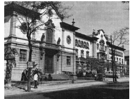
Fig. 169: Ângelo Bruhms e José Cortez. Escola Normal, hoje Instituto de Educação, Rio de Janeiro. 1926-1930. Fachada.
