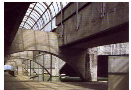
Fig. 33: Centro de Convenções de Pernambuco, 1977. 1ºprêmio: Ramalho Jr., Oba e Zamoner. Galeria interna.
