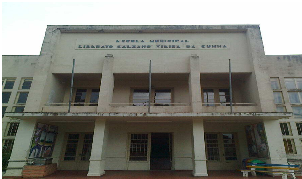
Foto 1: Vista da entrada da escola
