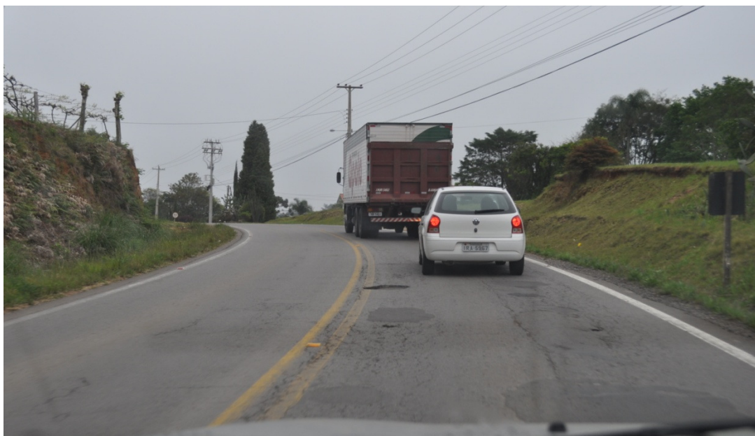
Foto 1 – RS-444 entre Bento Gonçalves, Monte Belo do Sul e Santa Tereza
