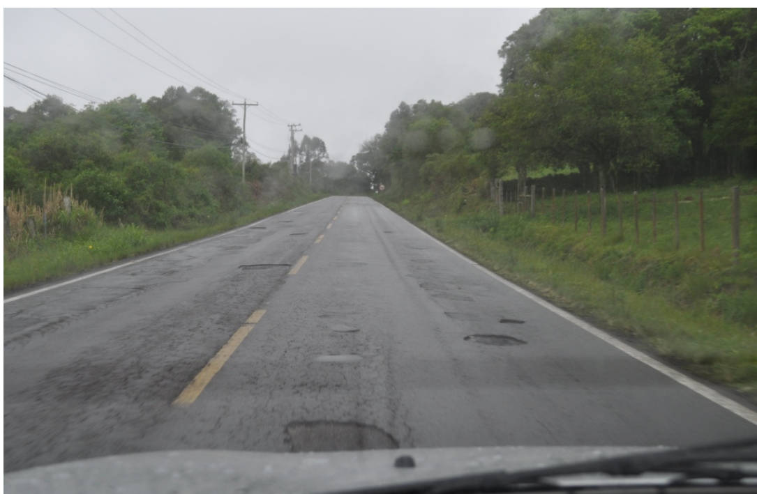
Foto 2 – RS-444 entre Bento Gonçalves, Monte Belo do Sul e Santa Tereza
