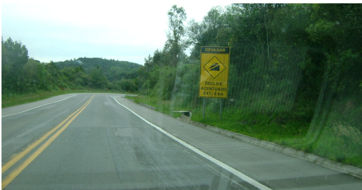
Foto 6 – Conservação e sinalização da BR-116 entre Caxias do Sul e São Marcos
