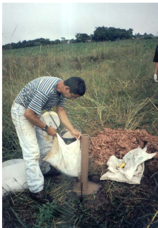
FIGURA 2.3 - Colocação do pré-filtro e revestimento na instalação dos poços de monitoramento. Área Campo Grande (Venâncio Aires, RS)
