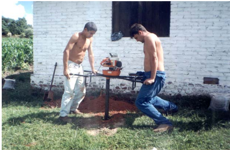
FIGURA 2.2 - Construção dos poços de monitoramento do aquífero freático por gradagem. Área Campo Grande, Mun. Venâncio Aires, RS
