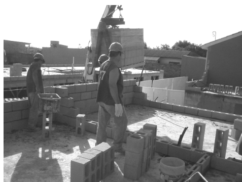
Figura 37 - Transporte vertical de materiais utilizando equipamento do fornecedor (guincho auto-propulsor)
