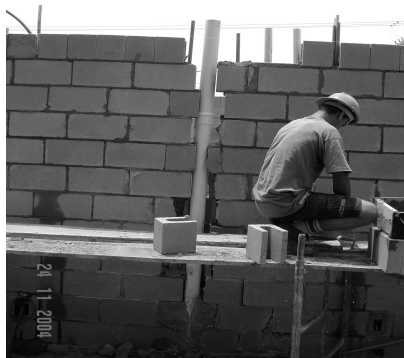
Figura 30: Blocos cortados para passagem da tubulação de esgoto na vertical.
