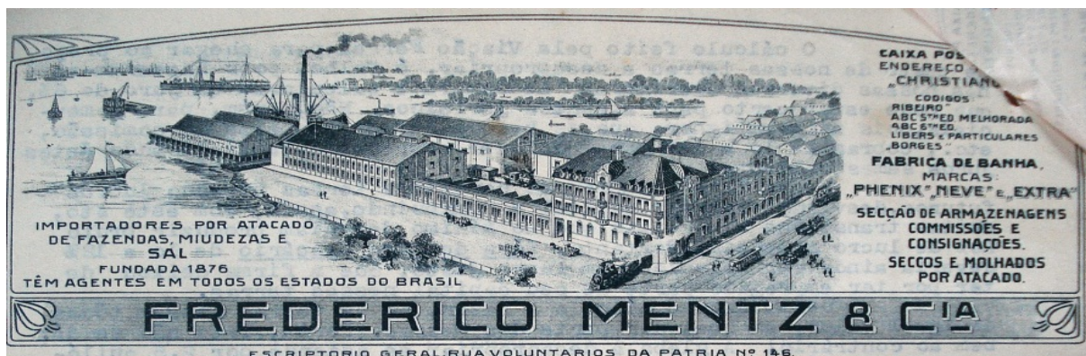
Figura 77: Desenho das instalações das empresas de Frederico Mentz em Porto Alegre (Navegantes). Fonte: Acervo documental da empresa F. Mentz, B. Mentz, DELFOS/PUCRS.
