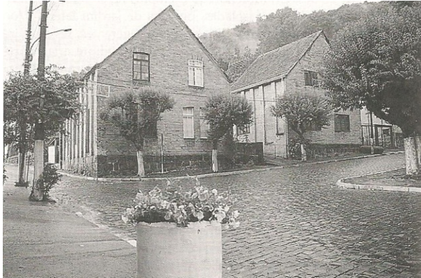
Figura 24: Vila Galópolis, lanifício São Pedro. Rio Grande do Sul. Fonte: Correia, 1998.p. 124.
