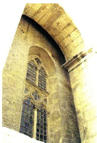
Figura 12 – Leon Battista Alberti – San Francesco, Rimini. Fachada lateral – relação entre as aberturas dos dois envoltórios.
