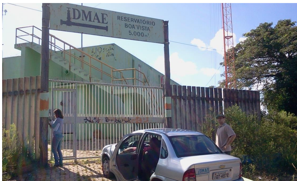
Figura 31 – Vista da reservação Boa Vista, 5.000 m³.
