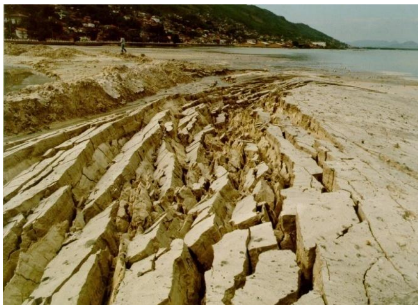
Figura 10 – Ruptura durante a execução do aterro hidráulico
