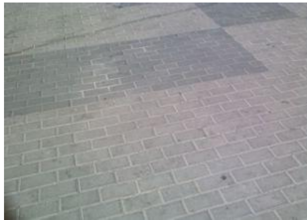
Figura 38 - Resultado da conclusão da troca do piso do Largo.
