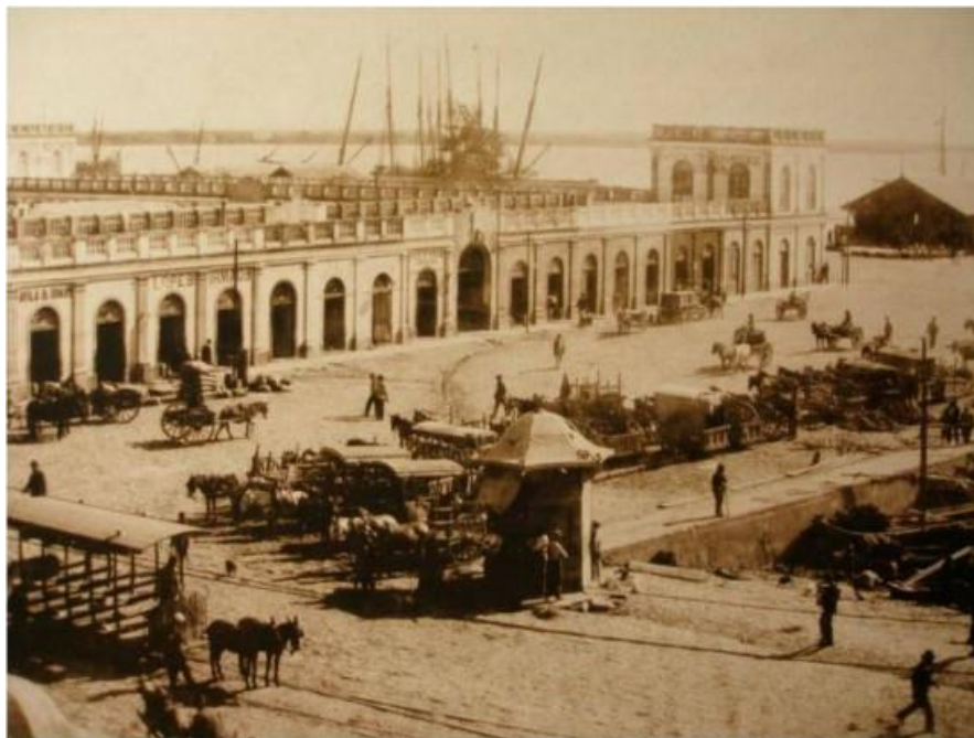
Figura 22 - Mercado Público Municipal de Porto Alegre, século XIX. Fonte: Acervo da Fototeca Sioma Breitman, 2012.
