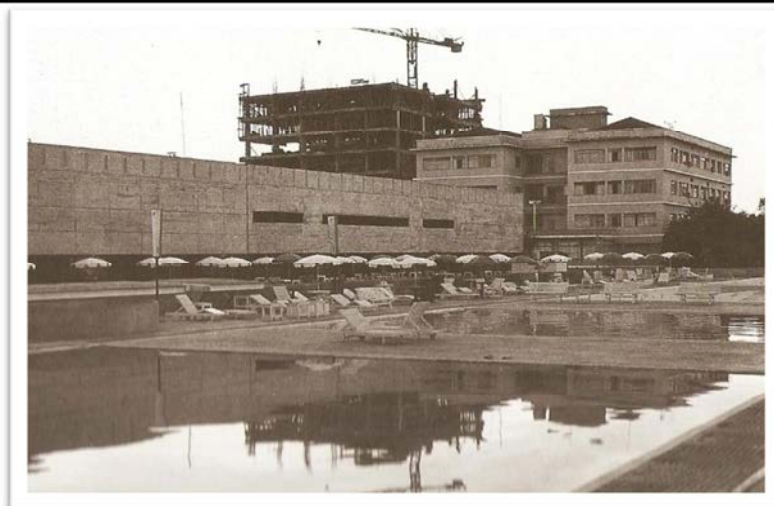
Figura 9.6: Sede Social Jôquei Clube Goiás e a praça das piscinas. Fonte: Artigas (2002) 20 .
