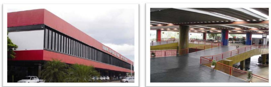
Figura 9.7: Estação rodoviária, fachada norte, passarelas internas e iluminação zenital. Fonte: Lemos (2007) 22 .
