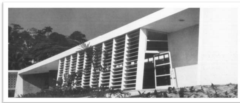
Figura 7.23: Brises mistos da lavanderia do Conjunto Residencial Pedregulho no Rio de Janeiro (1946), de Affonso Reidy. Fonte: Bonduki (2000) 40 .
