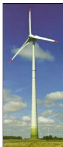
Figura 27: Aerogerador utilizado nos Parques Eólicos de Osório. Fonte: Sul (2009)
