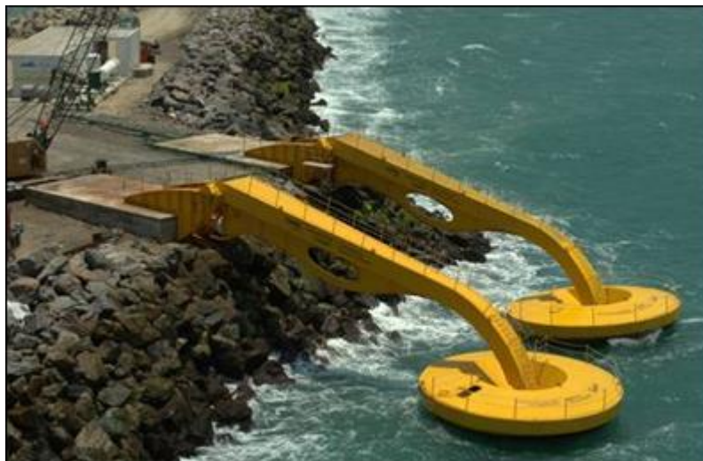
Figura 30: Usina (protótipo) de conversão das ondas oceânicas desenvolvida pela COPPE/UFRJ e implantada no Porto de Pecém, no município de São Gonçalo do Amarante/CE. Fonte: O GLOBO CIÊNCIA (2012)
