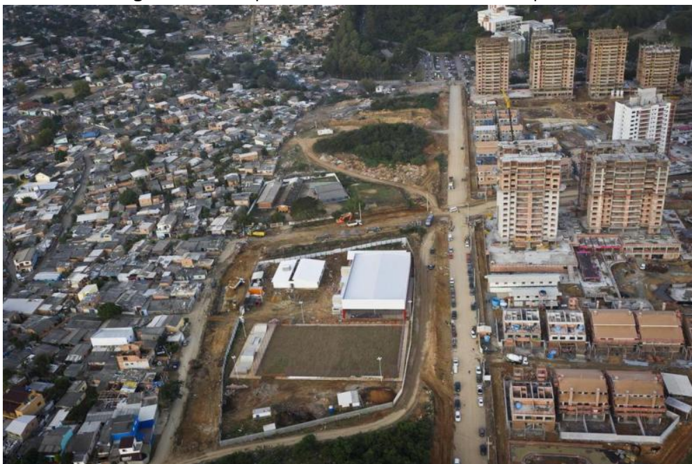
Figura 1 – Vista parcial do Bairro Bom Jesus à esquerda
