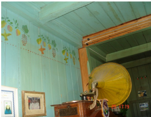
Figura 132 - Pintura interna da sala
