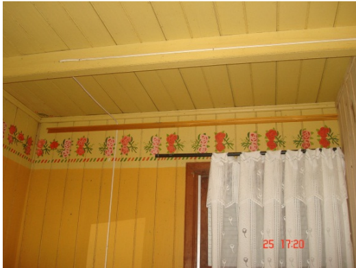
Figura 130 - Pintura interna do quarto
