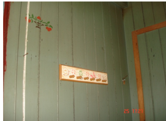
Figura 135 - Pintura interna do corredor
