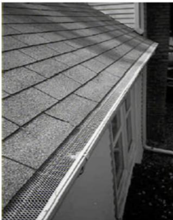
Figura 5 – Sistema de calha com tela horizontal
