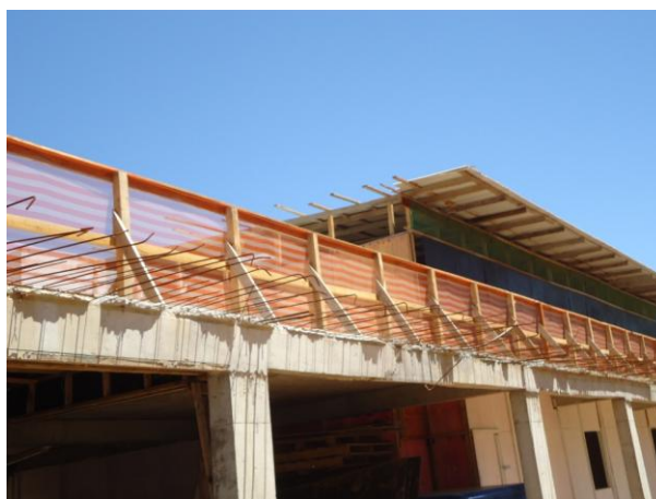
Figura 25 – Proteção coletiva em local onde há risco de queda na obra 5
