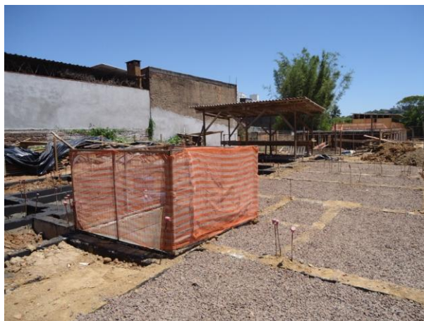
Figura 24 – Estágio da obra 5 no momento da visita
