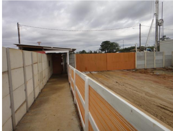
Figura 41 – Acesso de pedestres ao canteiro de obras 8
