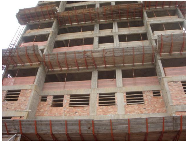
Figura 34 – Estágio da obra 7 no momento da visita
