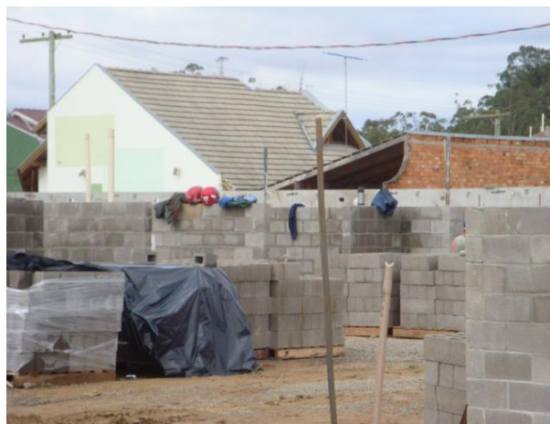
Figura 39 – Estágio da obra 8 no momento da visita
