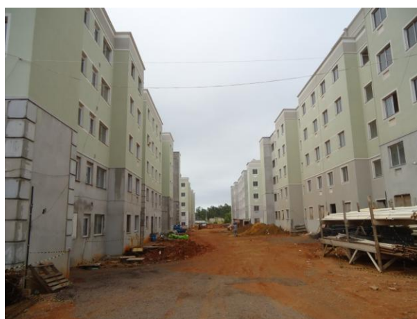
Figura 19 – Estágio da obra 4 no momento da visita
