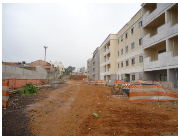
Figura 3 – Estágio da obra 1 no momento da visita
