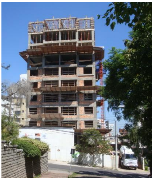
Figura 8 – Estágio da obra 2 no momento da visita
