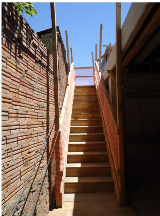
Figura 26 – Escada de acesso aos vestiários e sanitários do canteiro de obras 5
