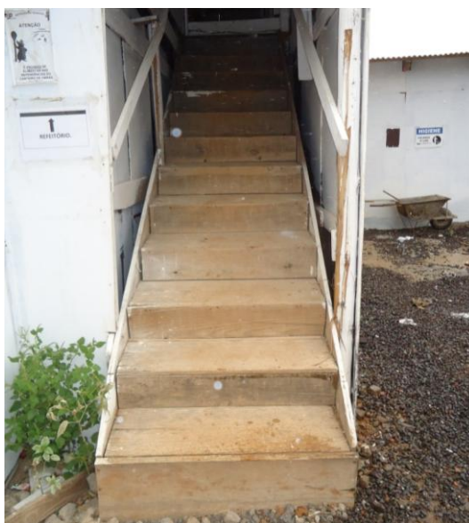
Figura 5 – Escada de acesso ao refeitório do canteiro de obras 1
