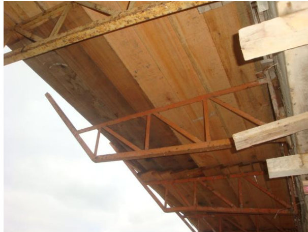
Figura 36 – Assoalho da plataforma de proteção secundária da obra 7
