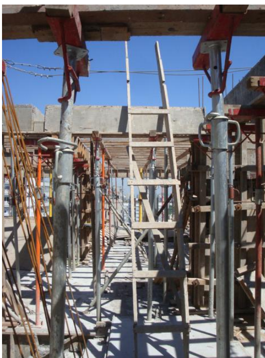
Figura 9 – Transposição de nível por escada de mão individual na obra 2
