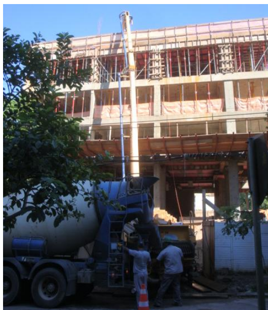
Figura 14 – Estágio da obra 3 no momento da visita
