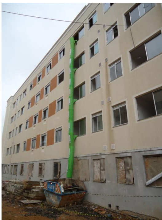
Figura 29 – Estágio da obra 6 no momento da visita
