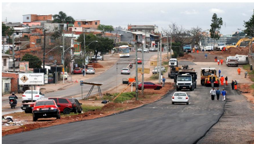
Figura 24: Trecho da Avenida Tronco em Obras. Fonte: Portal Transparência na Copa
