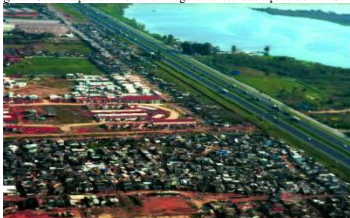
Figura 45: situação de moradia irregular antes das ações do PIEC.
