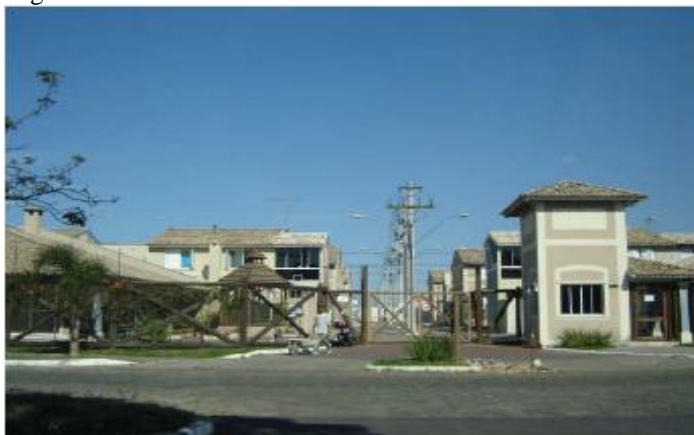
Figura 46: Moradias construídas através do PIEC.
