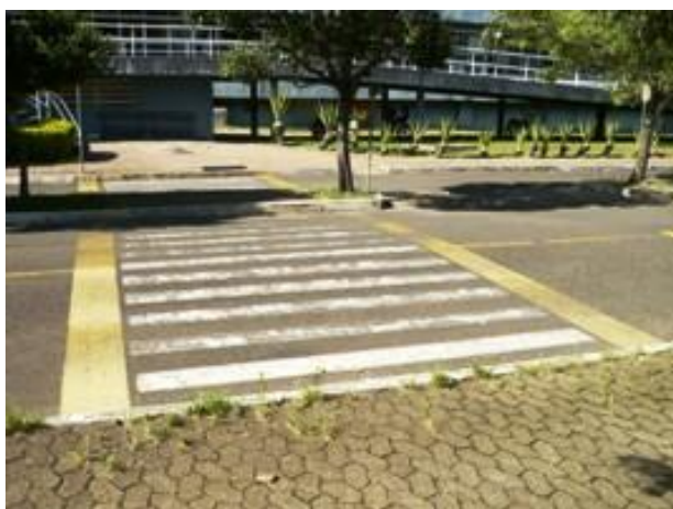
Foto 8– Faixa s/ rebaixamento – CAFF - Maninho
