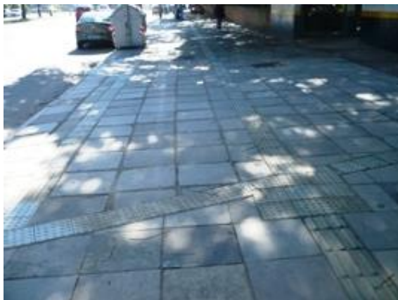
Foto 10 – Piso tátil – calçada externa Parobé - JC
