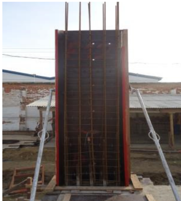
Figura 27 – Posicionamento do aço no pilar
