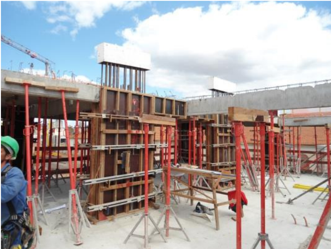
Figura 31 – Montagem de pré-fabricados
