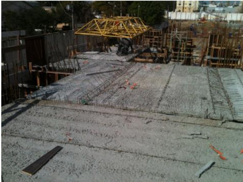
Figura 32 – Montagem pré-lajes
