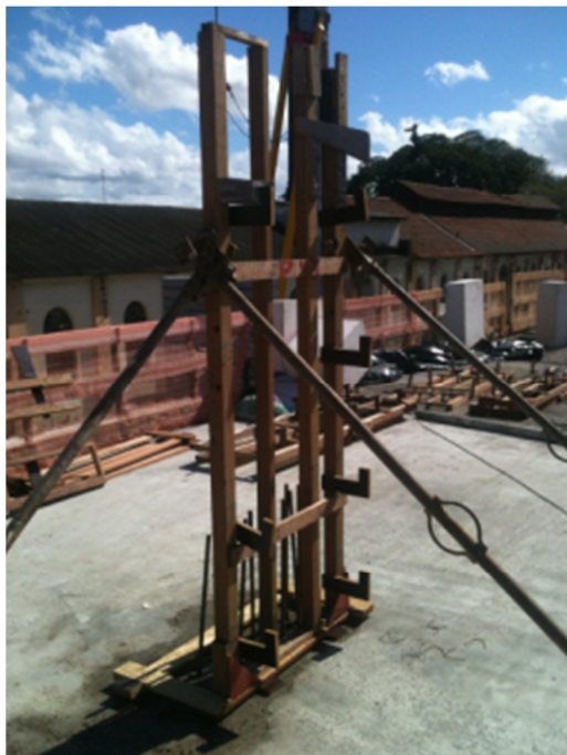
Figura 26 – Grade primária com aprumadores
