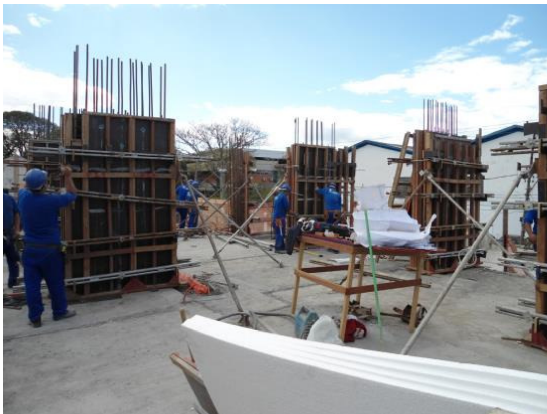
Figura 28 – Travamento dos pilares
