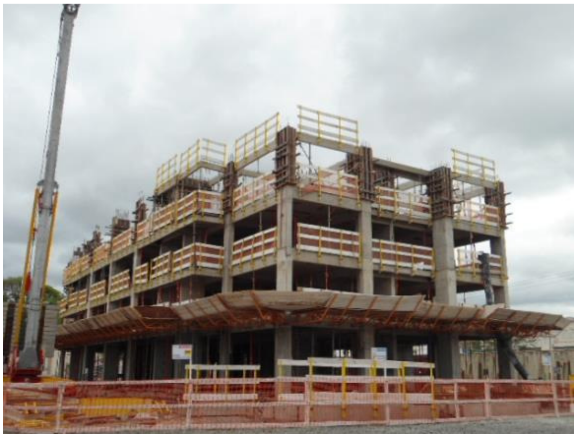
Figura 18 – Montagem pré-fabricados
