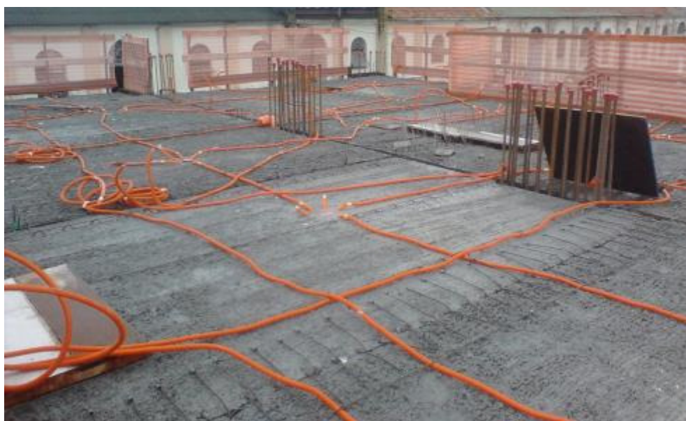
Figura 53 - Distribuição dos eletrodutos na laje, etapa 1, trecho 2
