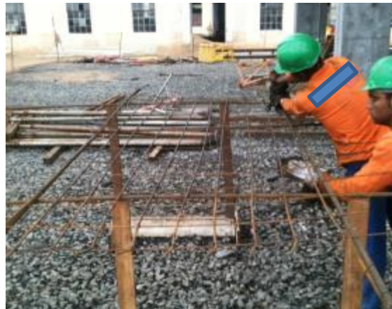
Figura 35 – Confeção malha armadura negativa laje na central de armação
