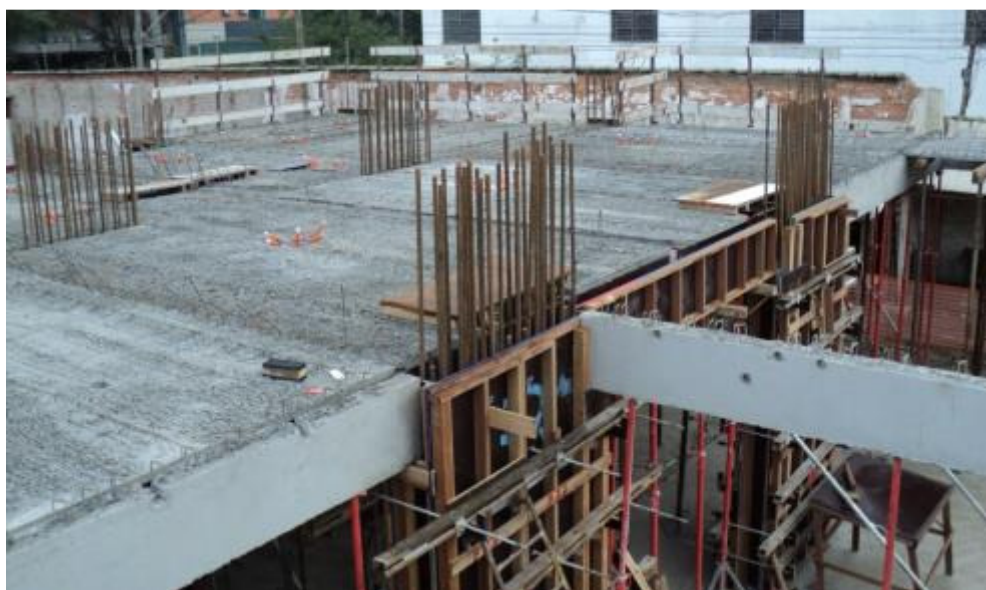
Figura 52 – Montagem pré-fabricados etapa 1, trecho 2, concluída
