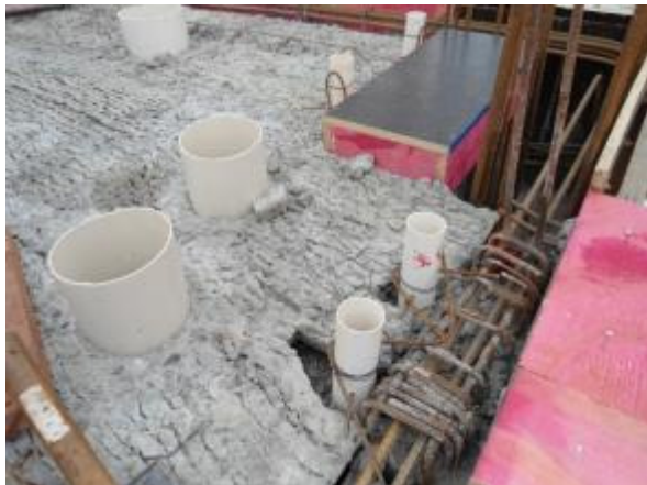
Figura 34 – Posicionamento barras nas vigas, tubos de passagem hidráulica, formas shaft e borda
