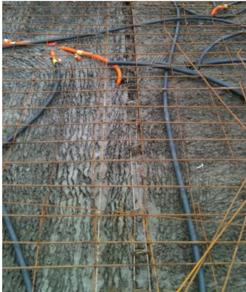
Figura 33 – Eletrodutos distribuídos na laje
