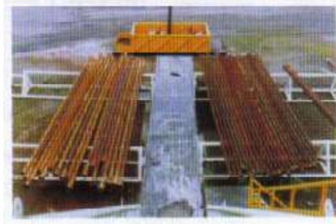
Figura 2.3 – Estaleiramento de tubos paralelo ao solo [Fonte: Thomas (2001)].
