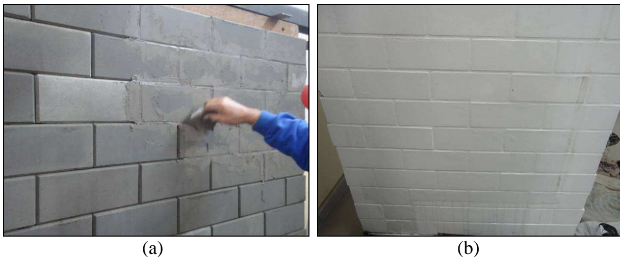
Figura BB.14 – (a) Segmento de parede do modelo E: (a) sendo rejuntado e (b) com a aplicação de três camadas de tinta acrílica.
