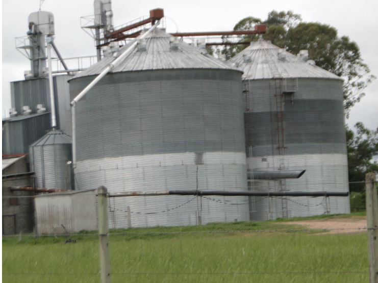
Figura 16- Estrutura de armazenamento - Silo. Tipo 3 (2ºSubdistrito – D. Pedrito, 2012).
