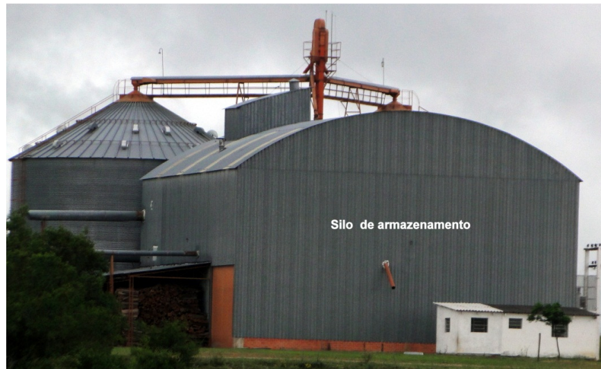
Figura 17- Estrutura de Armazenagem - Silo. Tipo 4 (Rincão Barreto – D. Pedrito, 2012)
