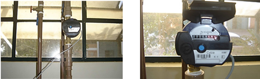
Figura 3.5 - Medidor Flodis \frac{3}{4} ”.
