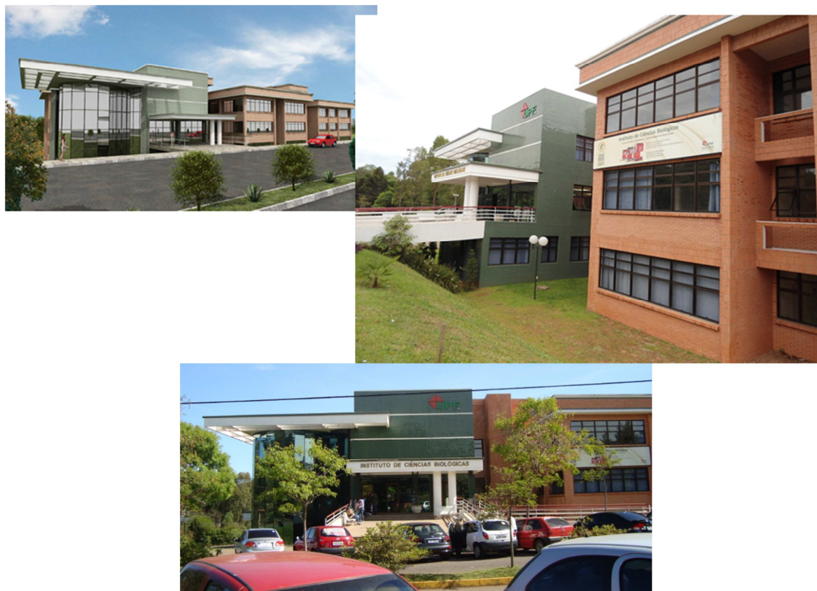
Figura 5.1 – Edificação piloto do estudo – ICB.
