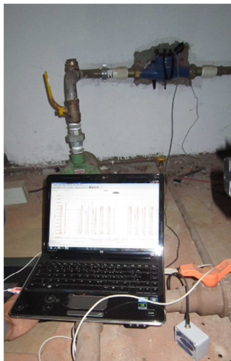
Figura 5.4 – Obtenção dos dados em hidrômetro instalado.
