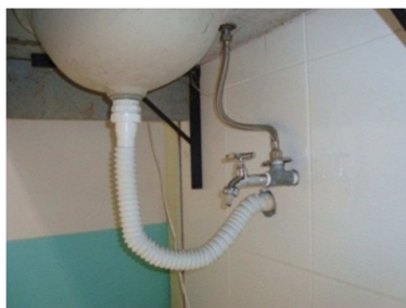
Figura 5.6 – Ponto de uso para limpezas na edificação piloto.
