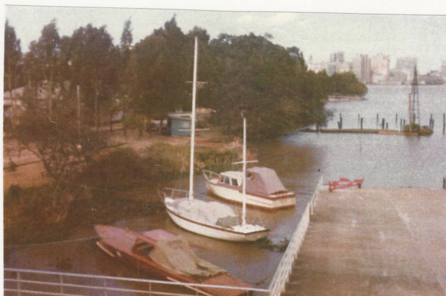
1976 – Trapiche para amarração de barcos Em construção.
