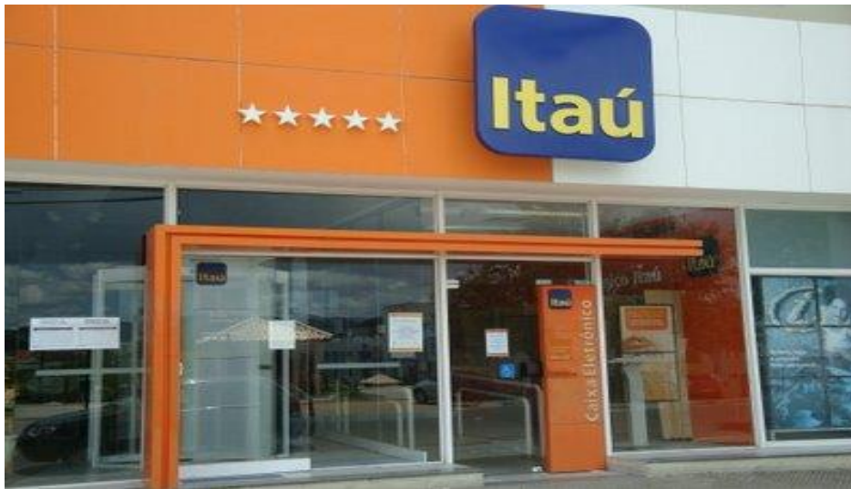
Figura 1 - Fachada Agência Assis Brasil Itaú Unibanco.
