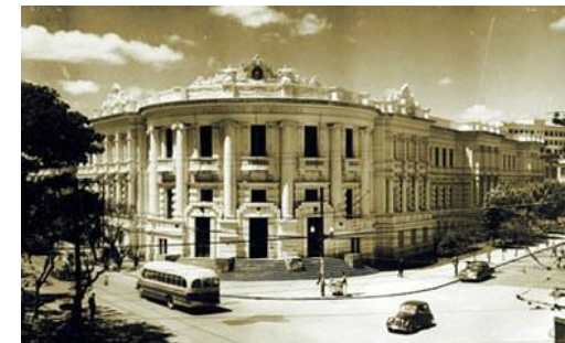
Figura 106 – Prédio da Faculdade de Medicina da UFRGS
