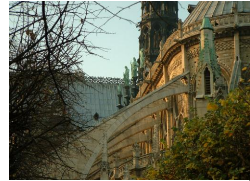
Figura 110 – Detalhe arcobotantes da Catedral de Notre Dame de Paris
