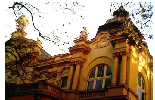
Figura 98 – Detalhe da fachada do prédio dos Correios e Telégrafos
