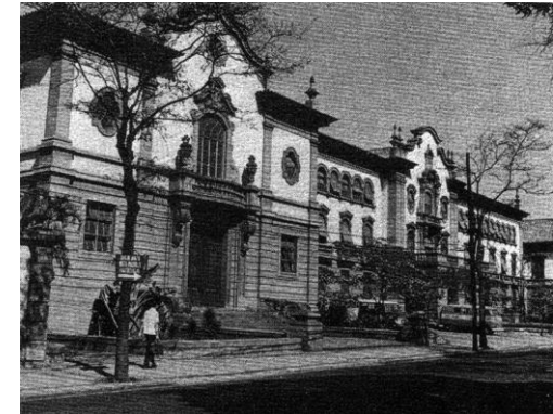
Figura 134 – Escola Normal, fachada
