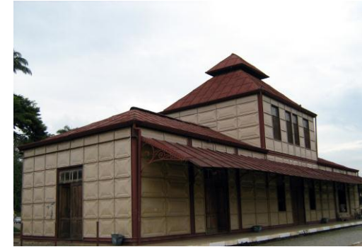
Figura 197 – Estação Ferroviária do Bananal
