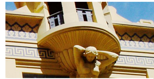
Figura 164 – Detalhe da Cariátide suportando o minarete, gregas, arabescos e gradis em ferro
