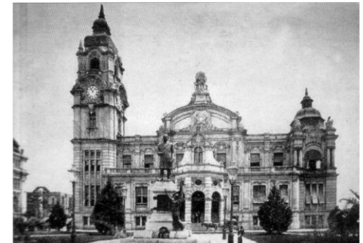
Figura 97 – Prédio dos Correios e Telégrafos
