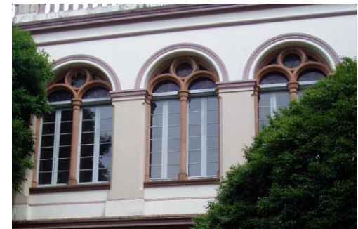
Figura 155 – Abertura do pátio interno da Cúria Metropolitana
