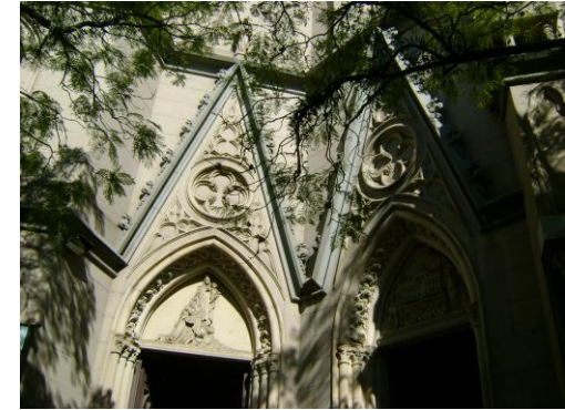
Figura 124 – Topo das portas de entrada
