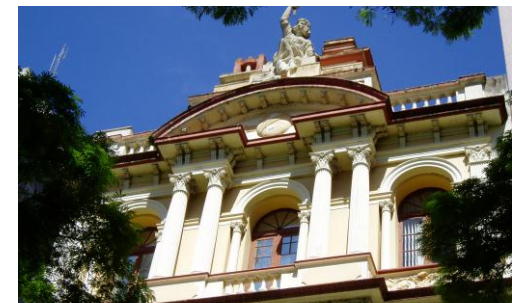
Figura 56 – Detalhe da fachada da antiga Sede do Jornal A Federação: profusão de elementos decorativos
