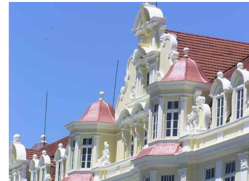
Figura 108 – Telhado de ponto elevado e mansardas
