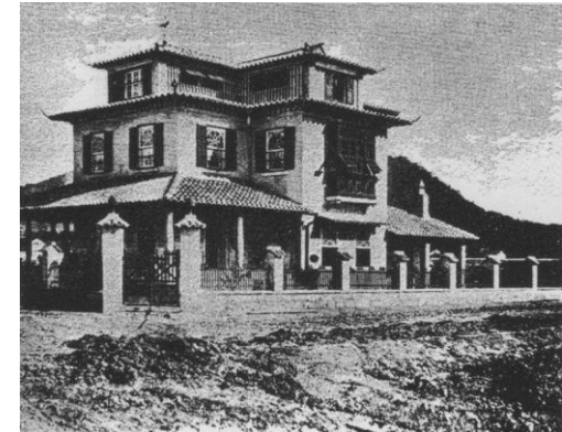
Figura 129 – Residência de Ricardo Severo no Guarujá
