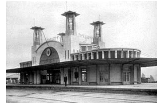
Figura 51 – Estação ferroviária de Mairinque
