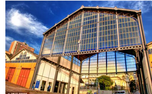
Figura 203 – Portão central do Cais do Porto
