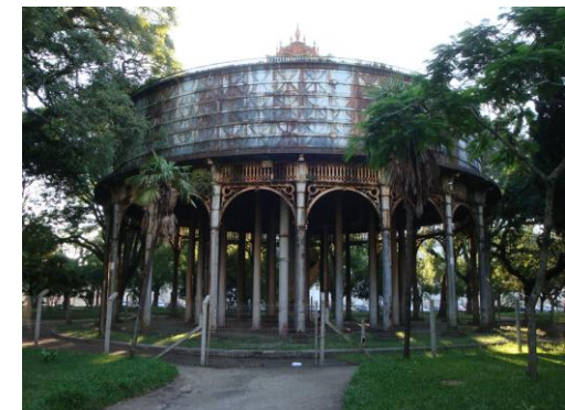
Figura 199 – Caixa d'água da cidade de Pelotas
